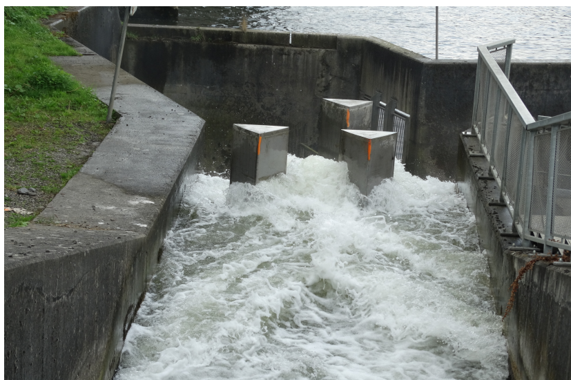
Figure 3 : Déflecteurs installés dans le débit d'attrait de l'échelle à poissons de Lixhe.
