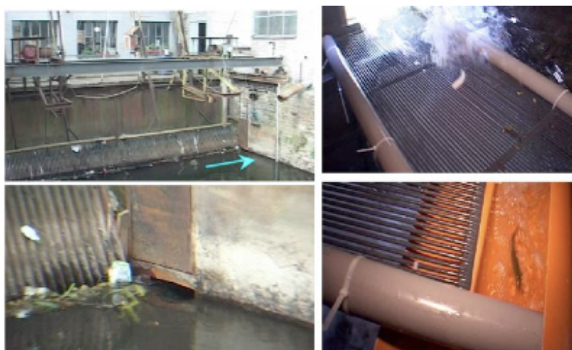
Figure 3. Vues (à gauche) de l'exutoire de dévalaison latéral (débit : 0,1-0,2 m 3 /s ; vitesse : 1-1,2 m 3 /s) aménagé dans le prolongement latéral de la grille de la prise d'eau de la centrale hydroélectrique Merytherm (10 m 3 /s maximum) sur l'Ourthe et (à droite) du système de récupération des poissons.
