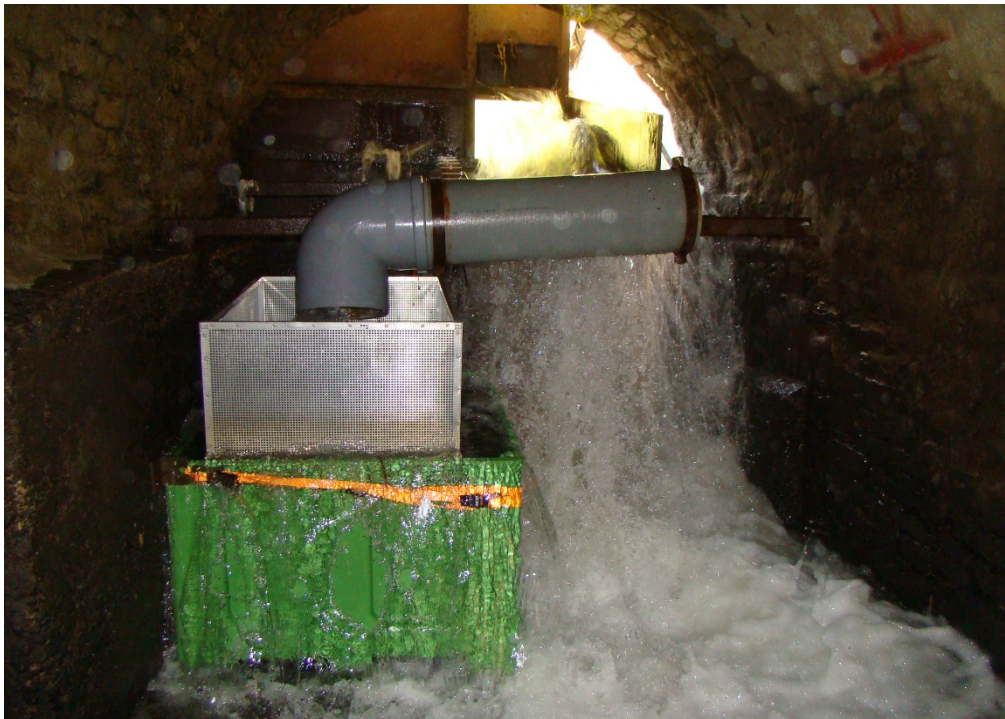
Figure 4. Le dispositif de piégeage à la dévalaison de Méry.
