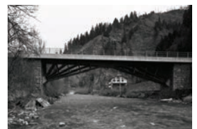
Pont Peiden Bad, Jürg Conzett.
