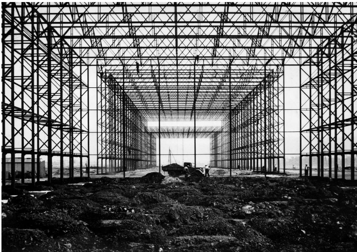
Figure 7 Ossature métallique standardisée à L'Exposition internationale des Techniques de l'Eau à Liège en 1939. (Centre d'Archives et de Documentation de la CRMSE, fonds de la Ville de Liège)
