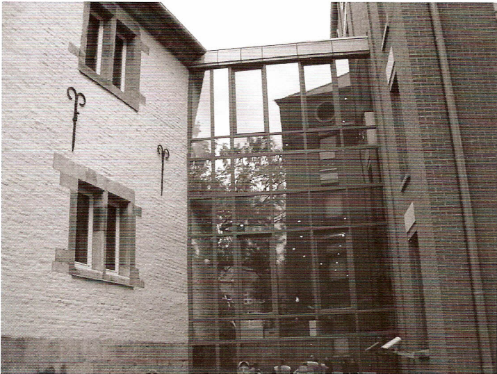
Ill. 8. Namur, ancien couvent des Célestines, connexion entre le couvent et l'ancien moulin de l'Étoile (sud), cliché de l'auteur, 2005.
