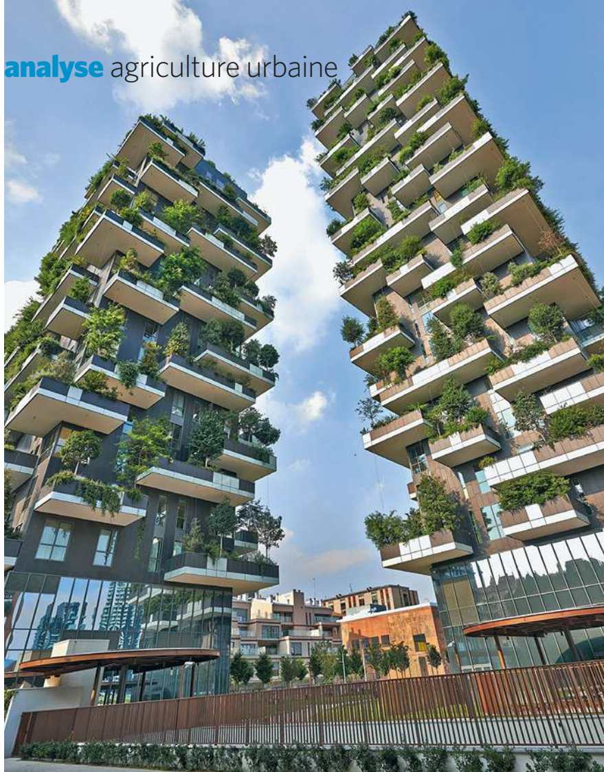
BOSCO VERTICALE (MILAN). L'architecte italien Stefano Boeri a niché l'équivalent d'un hectare de végétation sur deux tours d'habitation.
