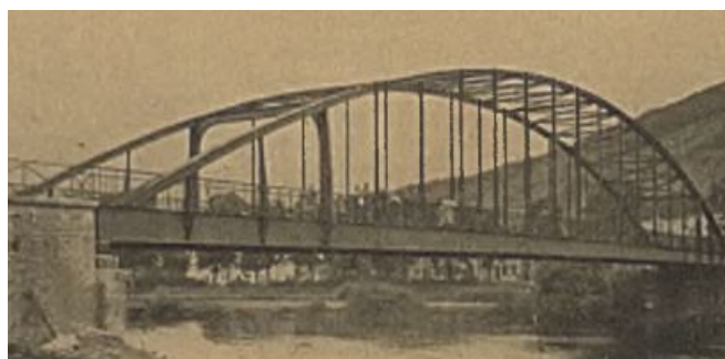
Figure 5 - Pont de Vireux (F): mise en œuvre précoce de la poutre Grey de 1 mètre (1916) (Photo : Revue Stahl und Eisen , n°11, 1920)
