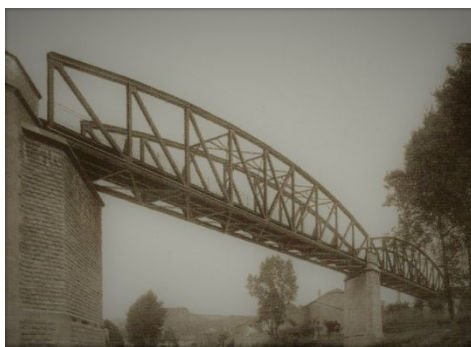
Figure 4 - Pont de Dommeldange (L): premier ouvrage à base de poutres Grey, 1905 (Photo : Archives Paul Wurth S.A.)
