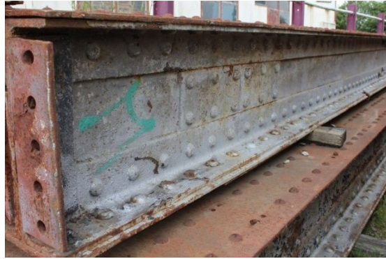
Figure 1 - Poutre à âme pleine rivetée (Photo : Collection privée)
