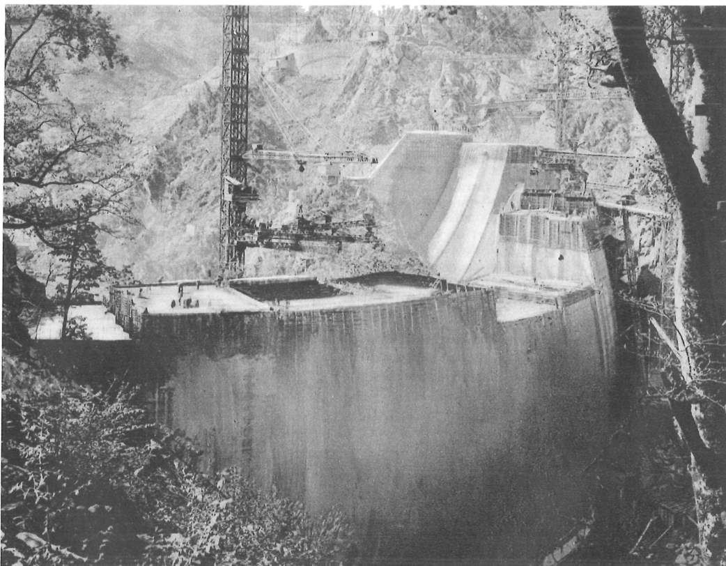
LE BARRAGE DE MAREGES (CORREZE), FRANCE.
