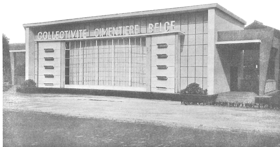
Le Pavillon de la Collectivité cimentière belge.
