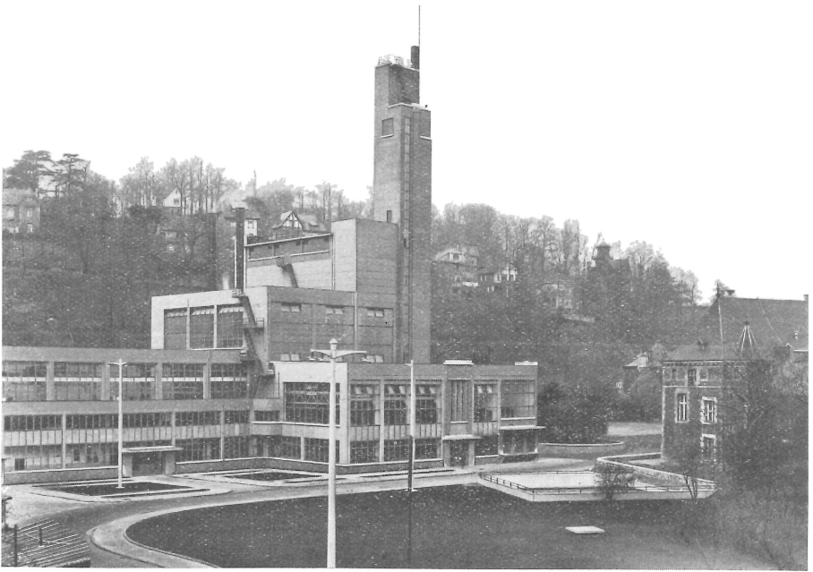
Fig. 3. — Vue de la Centrale et du Laboratoire de Thermodynamique.
