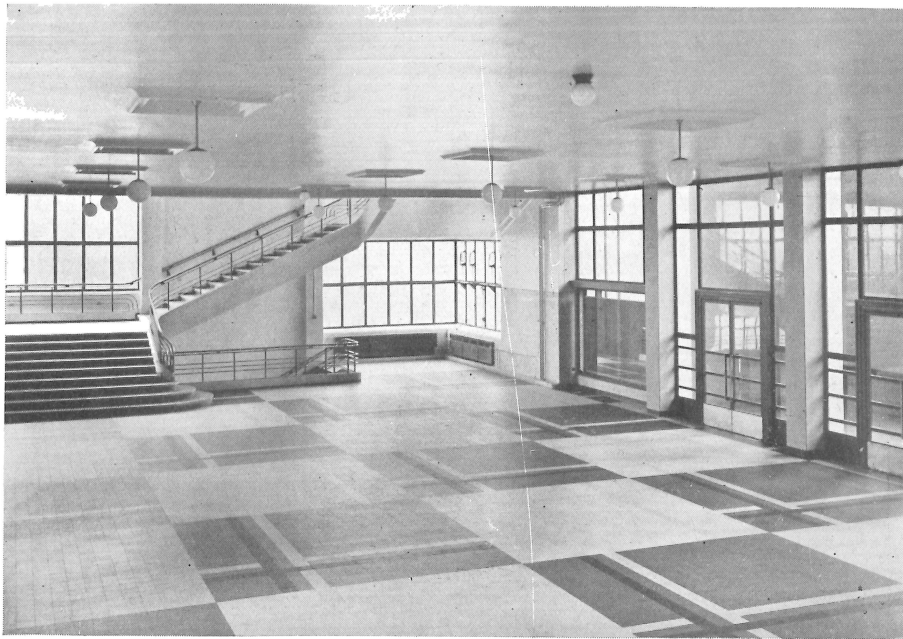
Fig. 16. — Institut du Génie Civil. Vue du hall d'entrée vers l'escalier principal.
