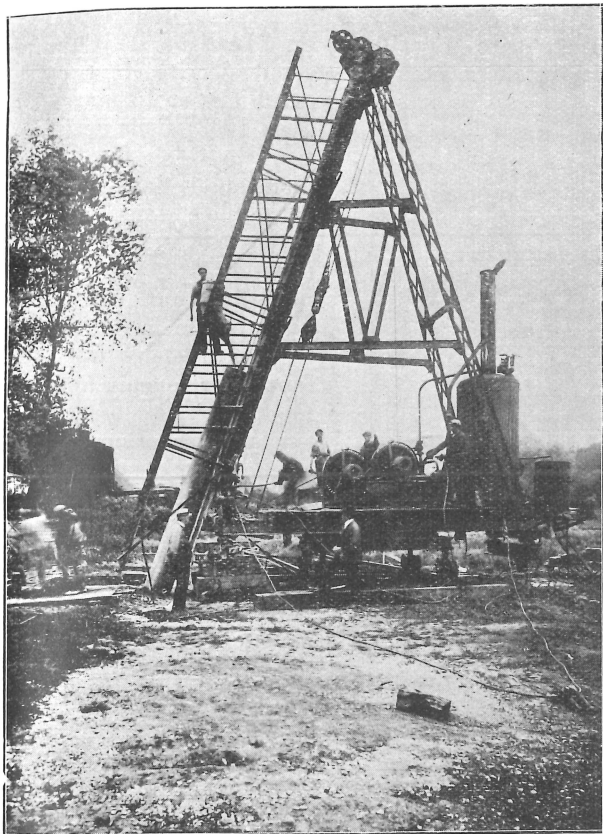
Fig. 4. — Battage de pieux Franki obliques (1930).
