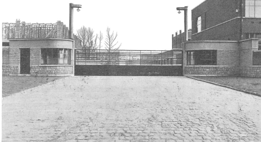
Fig. 16. — La porte baissante de 10 m à la rue du Val-Benoît (1937).
