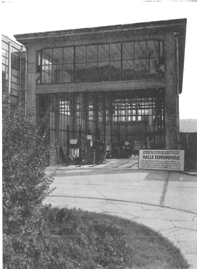
Halle expérimentale du Laboratoire d'essais des constructions du Génie Civil de Liège. Vue d'ensemble.
