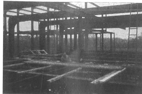
Fig. 104. Essai d'un nœud soudé de la charpente métallique de l'Institut du Génie Civil au Val-Benoît.
