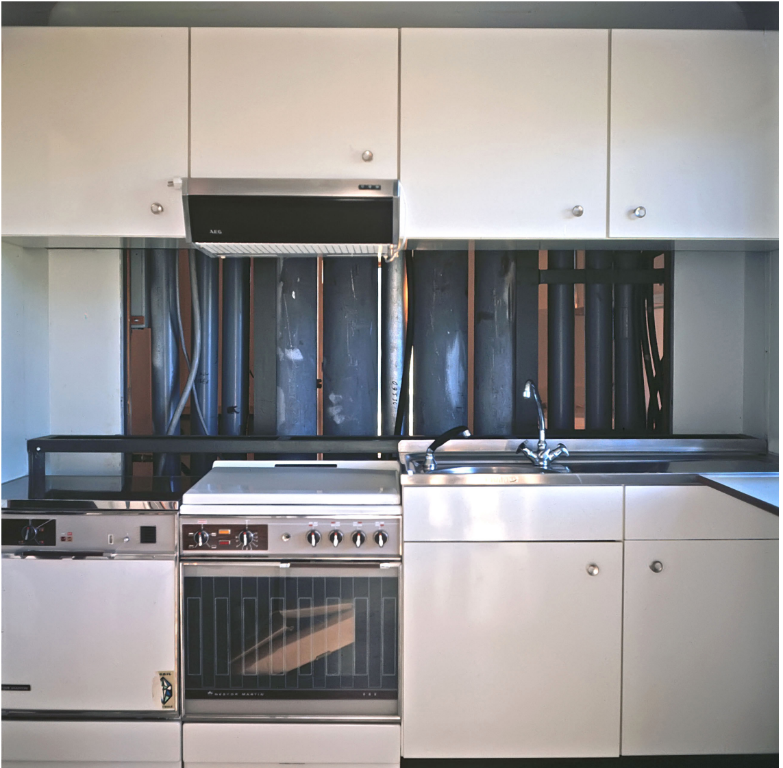
Fig. 97 : vue du mobilier et des appareils de la cuisine.
