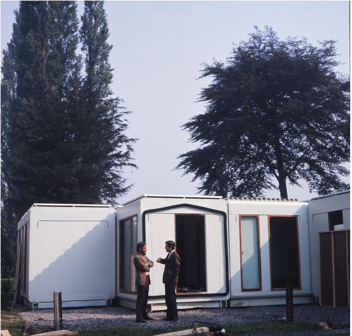
Fig. 81 : discussion entre ingénieurs avant la pose du dernier VM de la maison prototype.
