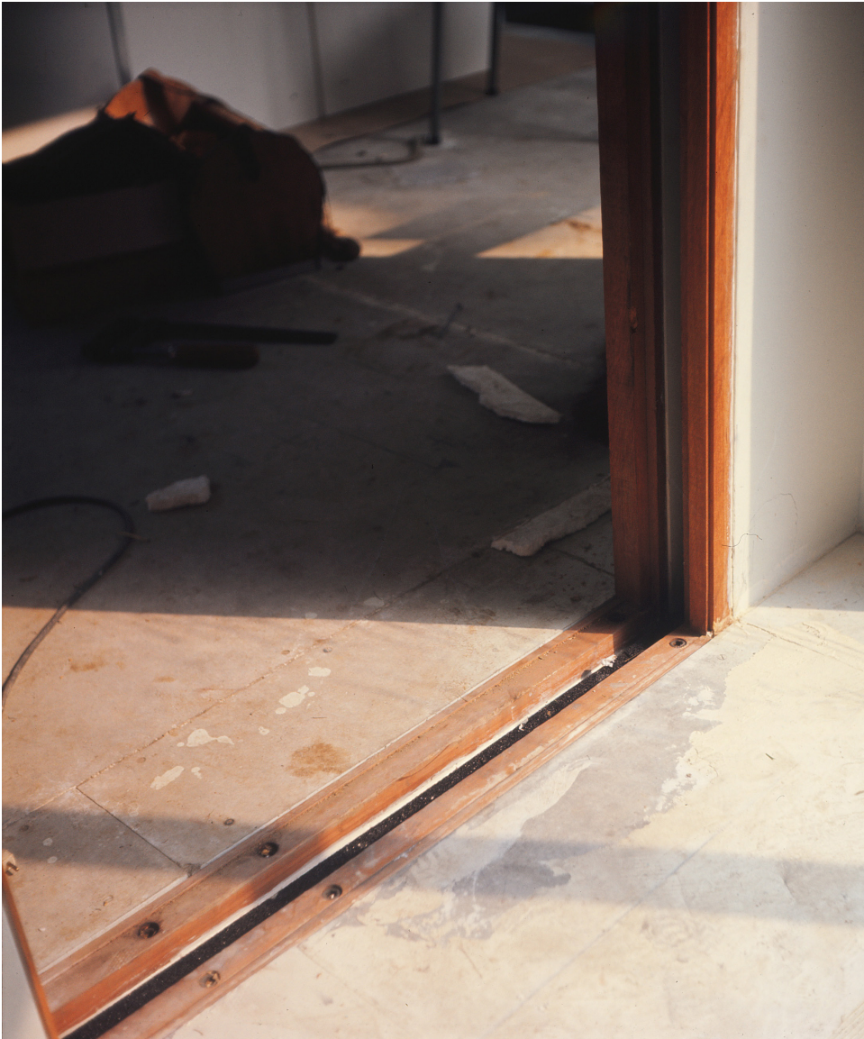
Fig. 90 : vue d'un joint entre deux VM avant fermeture.
