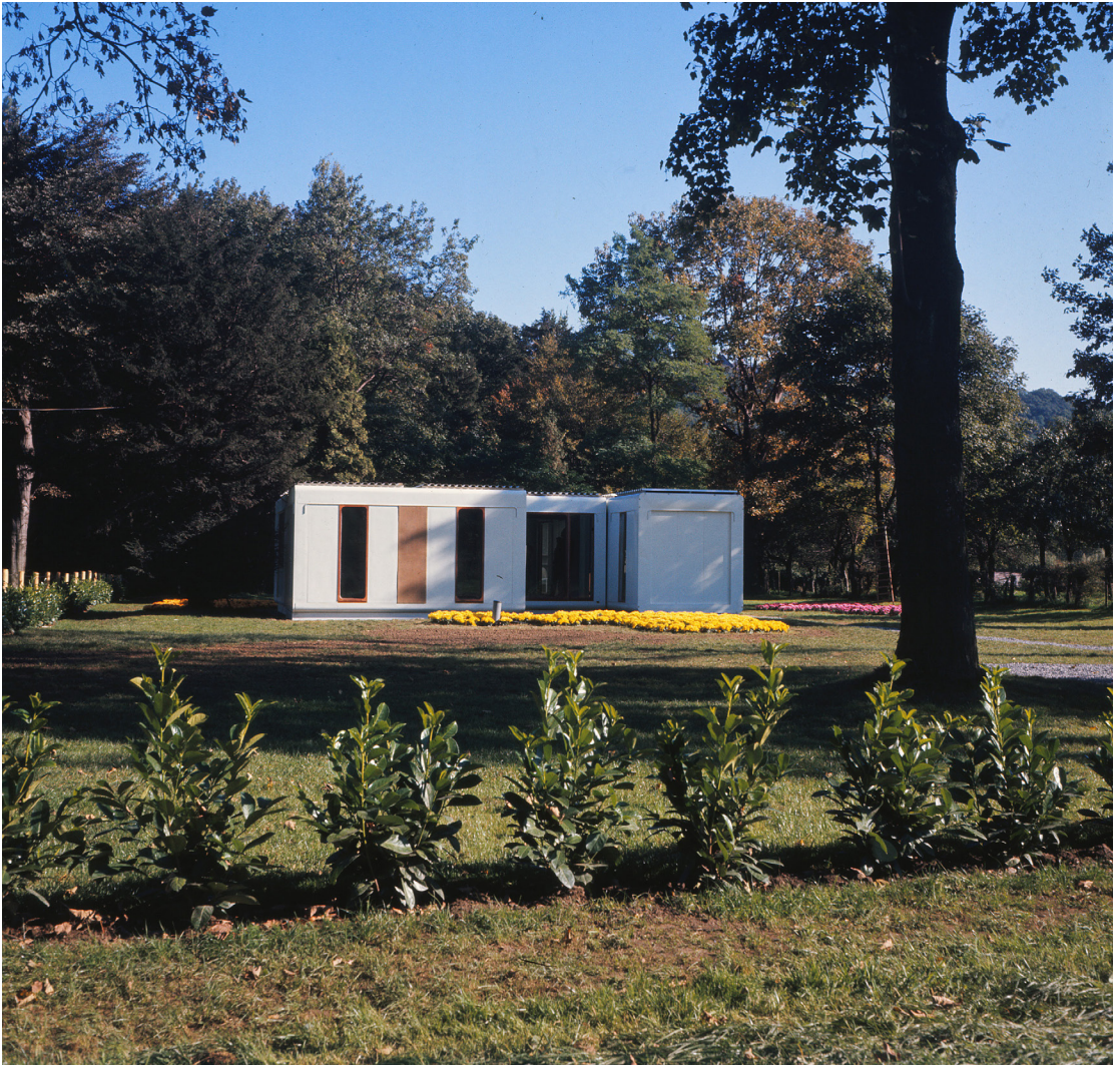
Fig. 86 : vue de la façade ouest de la maison prototype dans son environnement fleuri et forestier.
