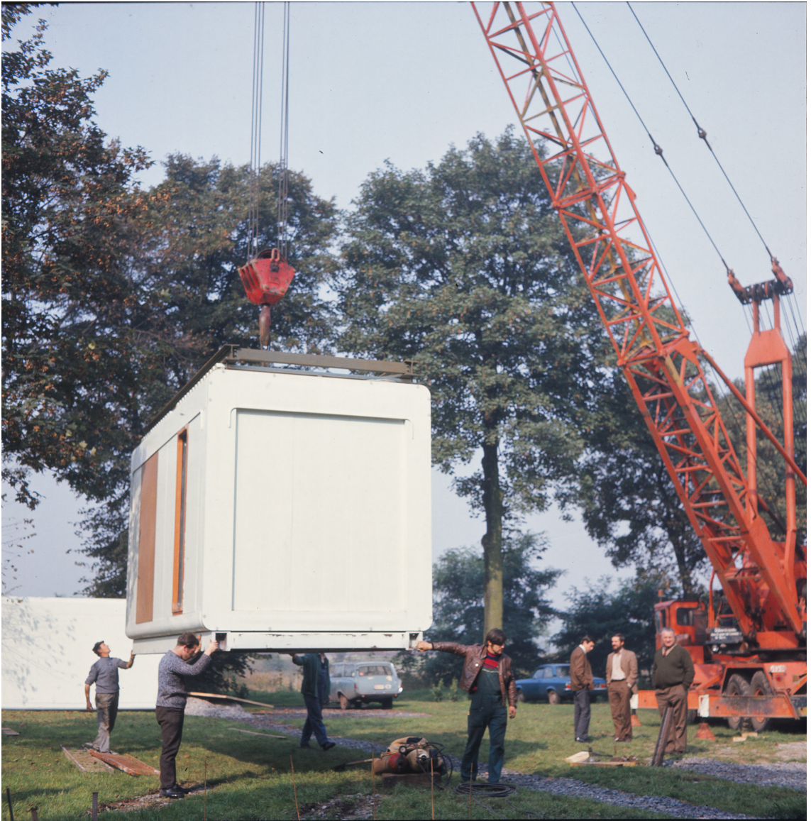
Fig. 78 : mise en place du premier VM de la maison prototype.
