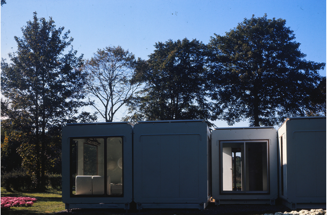
Fig. 87 : vue de l'ensemble des façades et des différents VM de la maison prototype.
