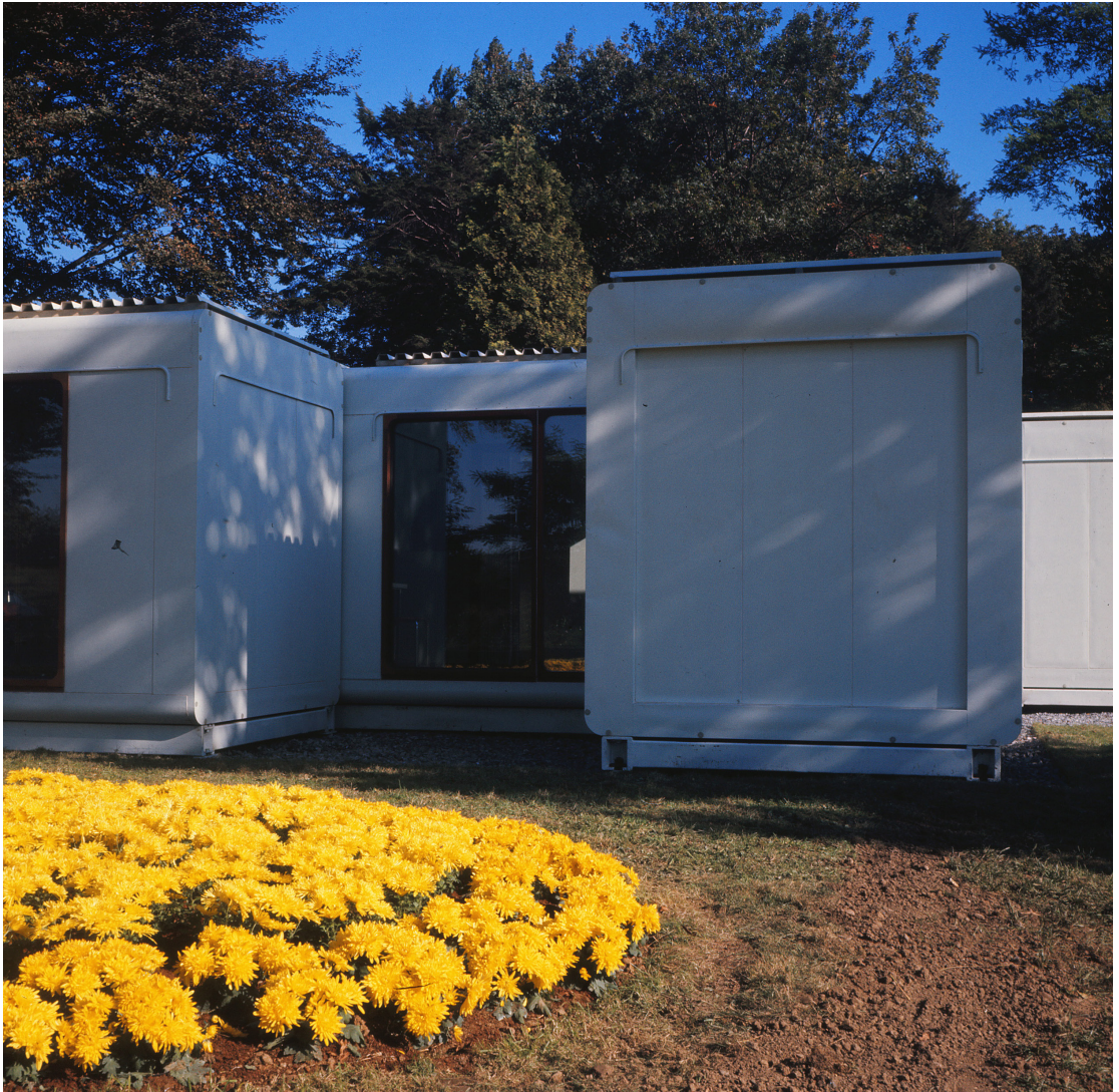
Fig. 89 : vue des façades ouest des différents VM formant la maison prototype.
