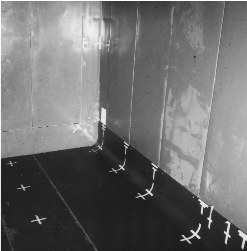
Fig. 74 : marquage pour l'emplacement des appareils de mesure à l'intérieur du VM.
