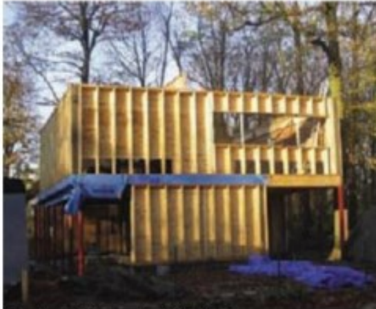
Illustration : Maison passive à Mariakerke, architecte: Giovanni Declercq, entrepreneur: Lab15
