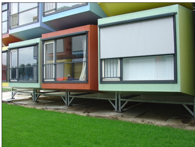
Figure 24. Construction modulaire à Utrecht
