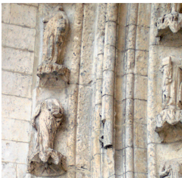
FIG. 53. — Collégiale Notre-Dame de Saint-Omer. Détail de la jonction entre le bandeau de voussure extérieur et le bandeau central sur la partie gauche du portail. © L. Nys.
