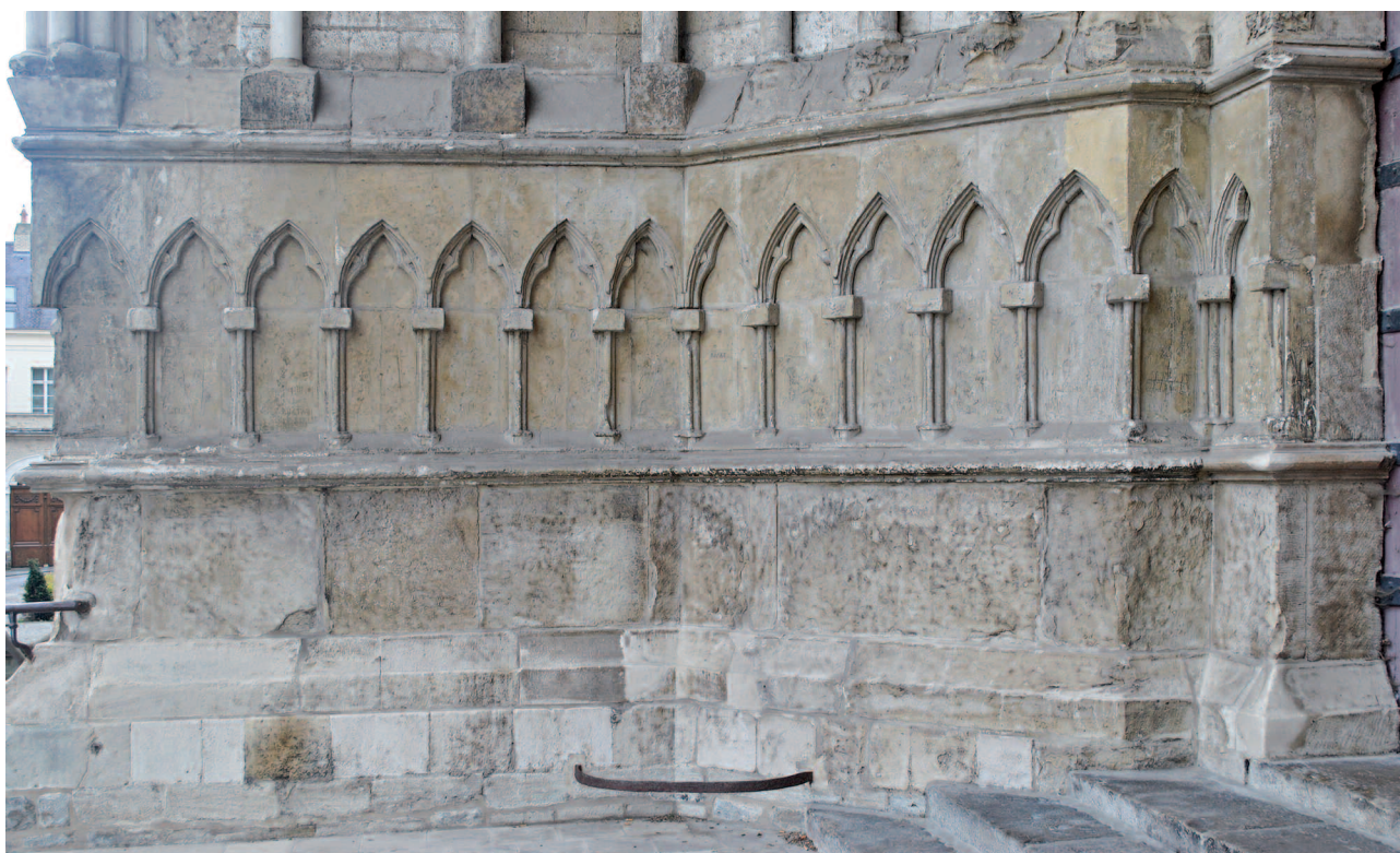
FIG. 15. — Arcatures aveugles de l'ébrasement gauche du portail sud, restitution de ca 1828. Manifestement destinées à être sculptées, ces arcatures sont restées en l'état. © L. Nys.
