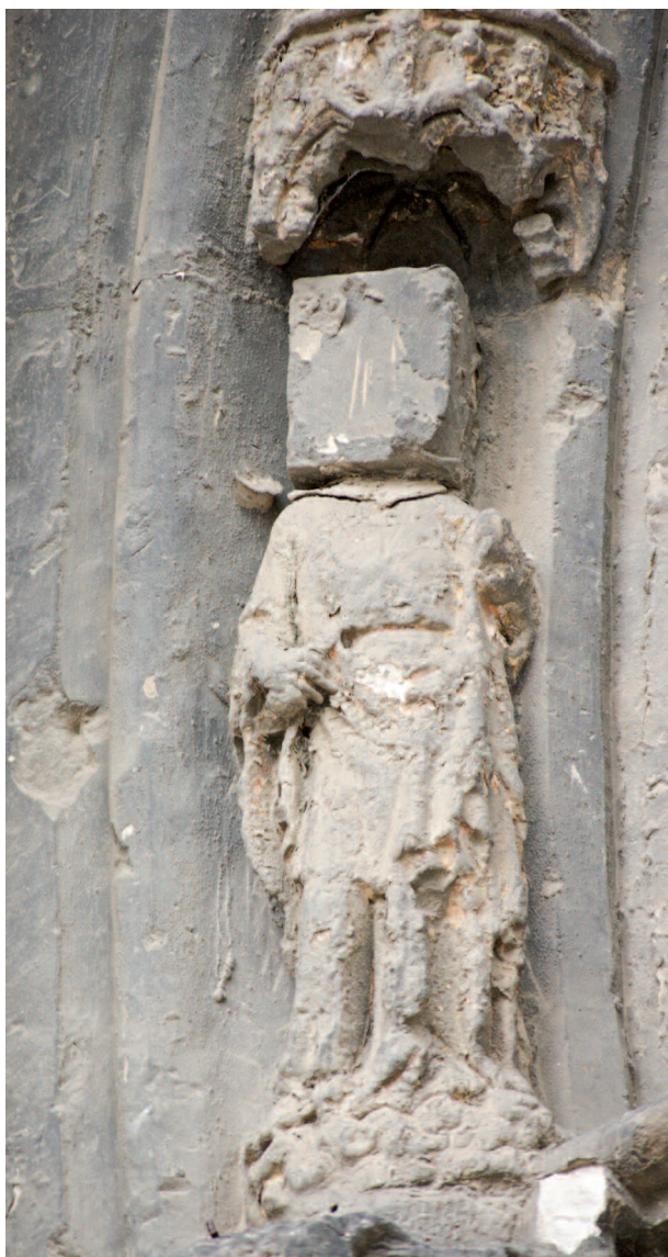
FIG. 39. — Saint-Omer, église du Saint-Sépulcre, portail occidental. Statuette d'ange à l'archivolte, ca 1380. La tête, brisée, a été remplacée par un petit bloc cubique de pierre blanche, laissé en l'état.
