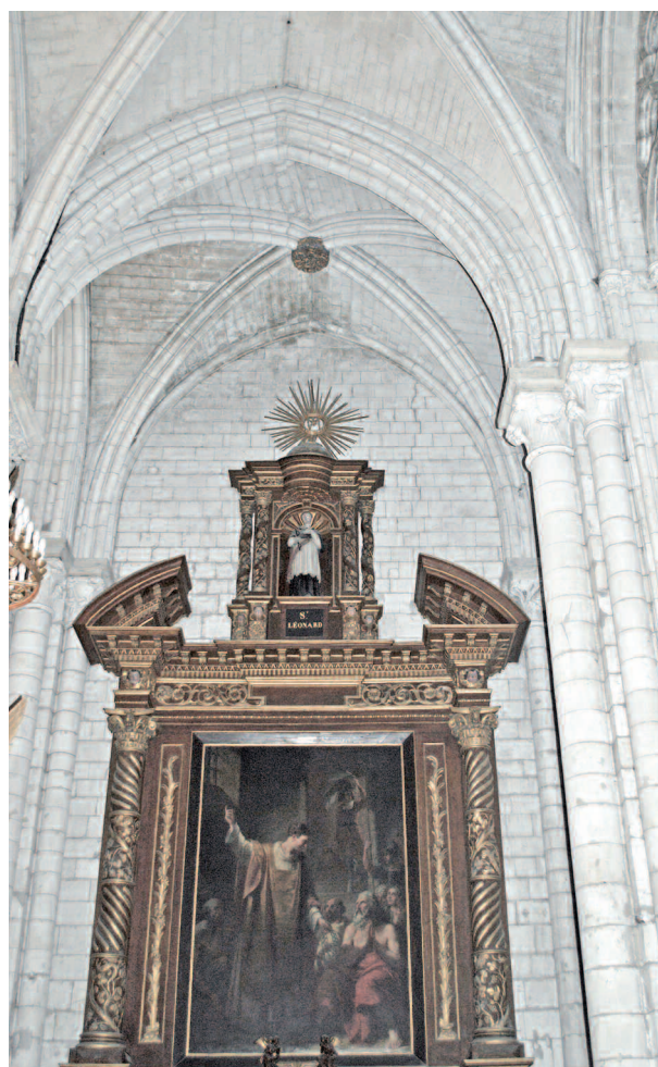
FIG. 10. — Vue de la chapelle d'Urgel, dédiée à sainte Marie l'Égyptienne, par la suite à saint Léonard, deuxième moitié du XIV e s. L'arc doubleau séparant en profondeur les deux travées et les ogives, rétrécis du côté sud, témoignent clairement de l'antériorité de la façade méridionale sur laquelle est venue se greffer la chapelle. © L. Nys.
