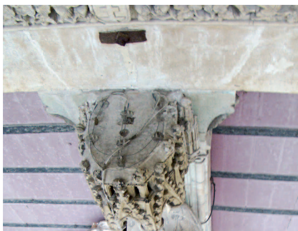
FIG. 41. — Détail de la partie centrale du linteau (vu du haut), avec l'encre métallique. Des traces de sels de cuivre sont repérables sous ledit linteau, de part et d'autre du dais sommant la Vierge à l'Enfant du trumeau.
