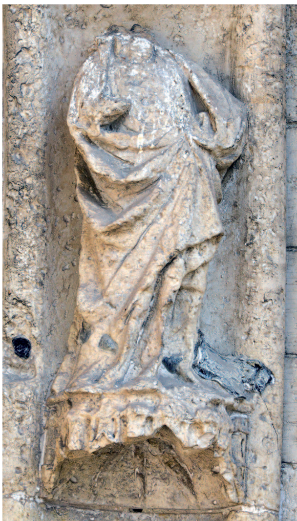
FIG. 55. — Statuette du bandeau de voussure extérieur (partie droite) (VEb3) du portail sud. À la base est visible un énorme « chert » (inclusion de silex). © C. Peterolff.
