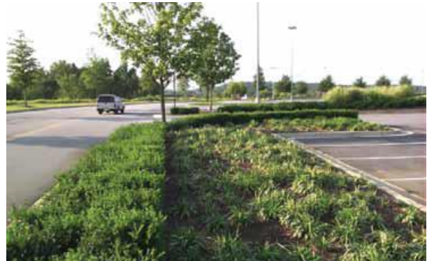
Figure 27 : espace de traitement en biorétention en limite de zone de stationnement.
