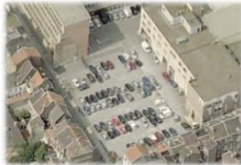
Vue avant les travaux
