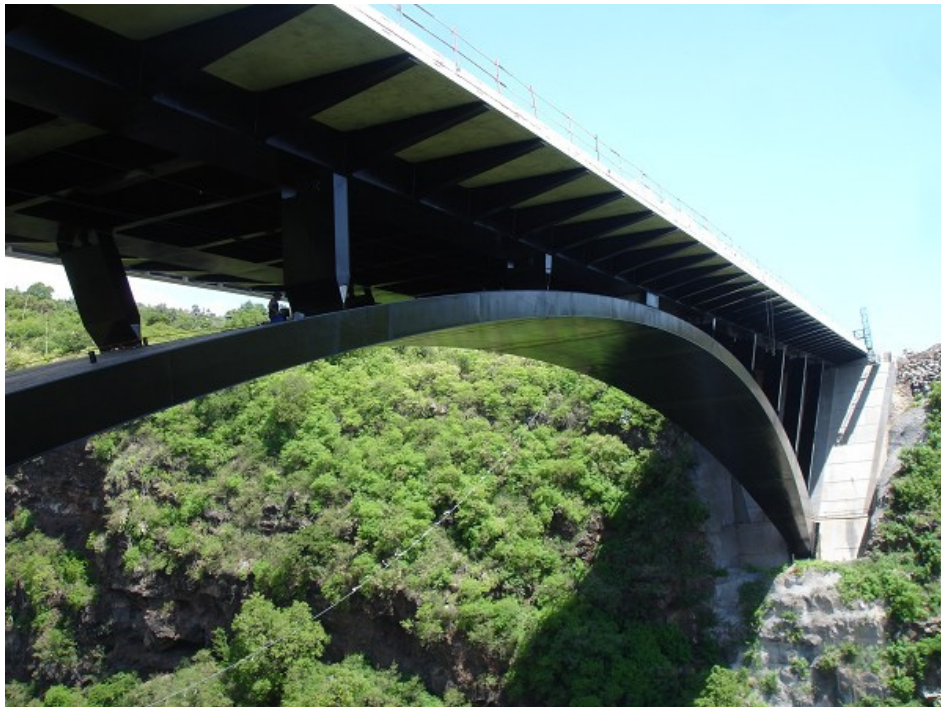
Figure I-1 : Viaduc de la Ravine-Fontaine (tirée de [20])
