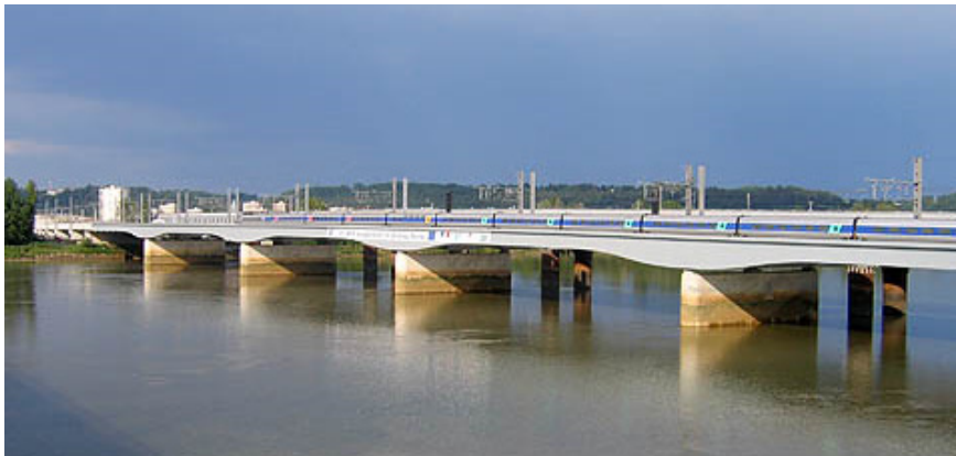
Figure I-4 : Pont ferroviaire à quatre voies sur la Garonne (tirée de [17])
