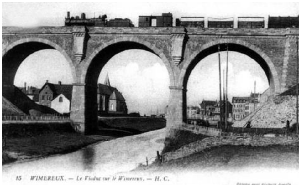
Le viaduc sur le Wimereux vu vers la côte. Entre deux arches, l'église : modernité et tradition font-ils autonomie ? Premières décennies du XX e siècle, Collection particulière
