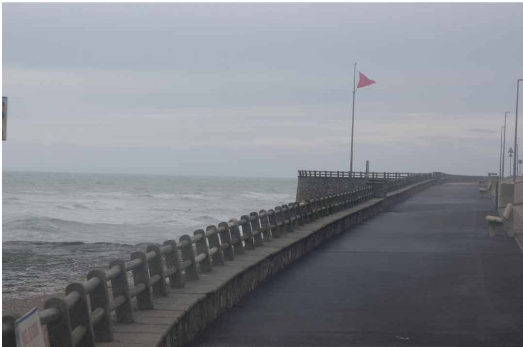
Digue-promenade d'Ambleteuse (Pas-de-Calais), juillet 2017.
