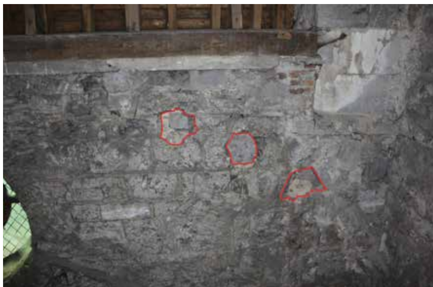
Fig. 33.- Trous de boulin des pannes d'une ancienne charpente. © Antoine Baudry, 2014.
