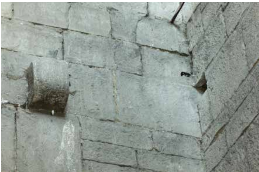
Fig. 11.- Vestiges de l'ancien plancher du deuxième étage de la tour nord. © Antoine Baudry, 2014.
