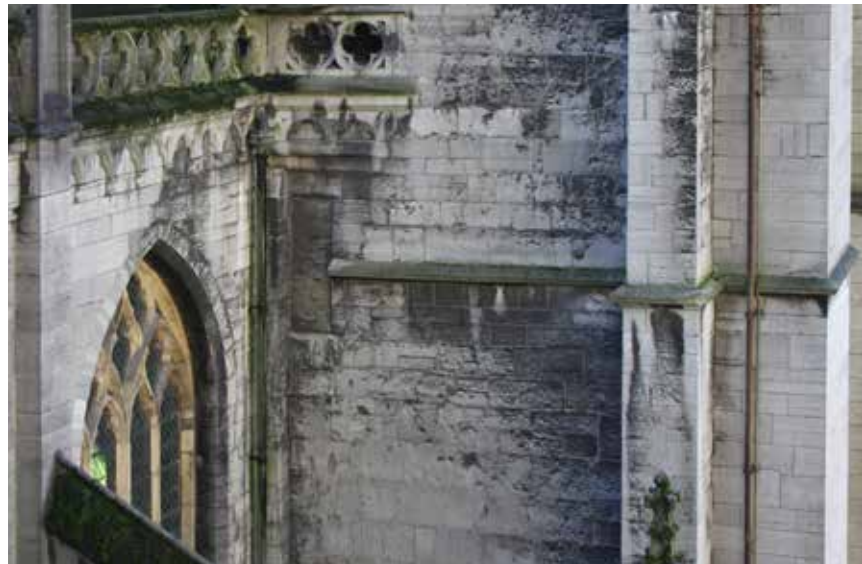
Fig. 9.- Porte bouchée au deuxième étage de la tour nord, débouchant sur le clair-étage de la nef.
