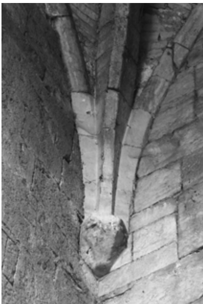
Fig. 27.- Le tas-de-charge de la voûte du deuxième étage de la tour nord. © Antoine Baudry, 2014.
