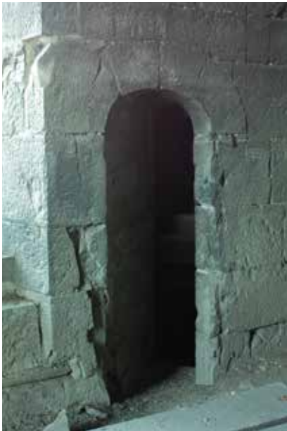
Fig. 7.- Porte biaisée au premier étage de la tour nord.
