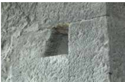
Fig. 28.- Encoche trapézoïdale dans l'ébrasement d'une fenêtre du premier étage de la tour nord. © Antoine Baudry, 2014.
