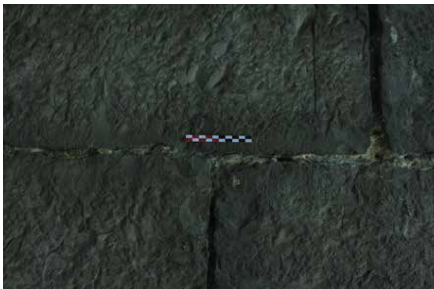
Fig. 32.- Taille à la broche sur les parements du deuxième étage de la tour sud. © Antoine Baudry, 2014.
