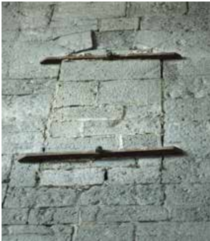
Fig. 26.- La porte murée du deuxième étage de la tour nord. © Antoine Baudry, 2014.
