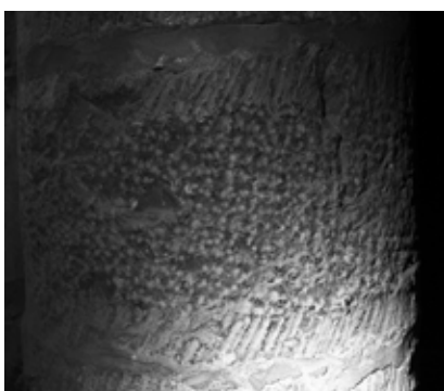
Fig. 31.- Taille au ciseau grain d'orge (?) sur le noyau d'une des marches du deuxième groupe de l'escalier nord.
