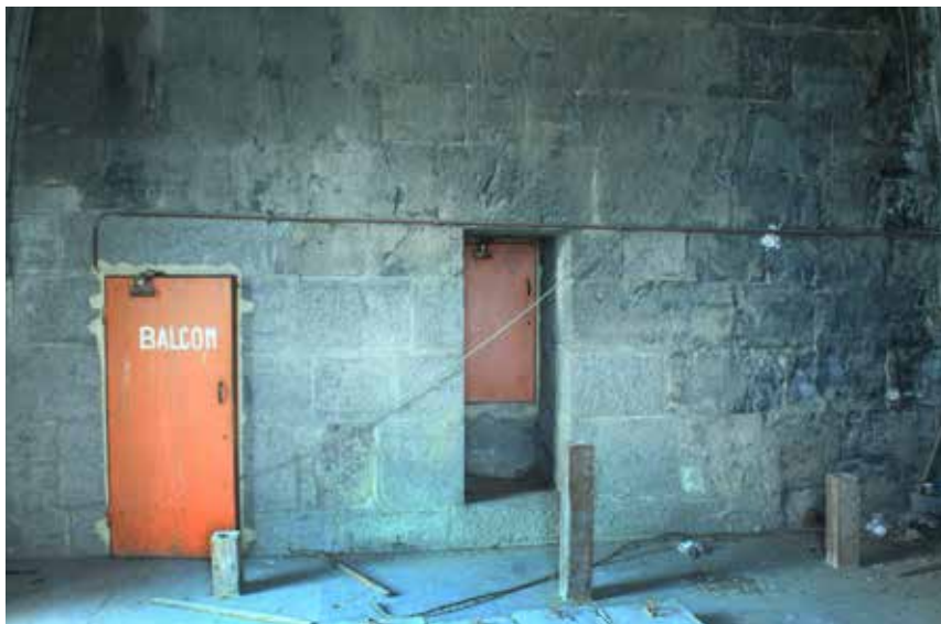
Fig. 25.- Reparementage et traces d'incendie au premier étage de la tour sud.
