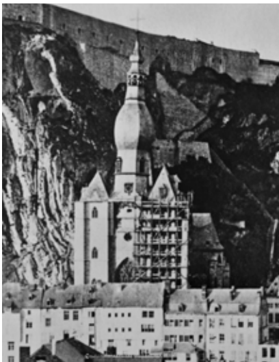
Fig. 22.- Reparementage de la tour sud vers 1868-1870. © IRPA-KIK, Bruxelles.
