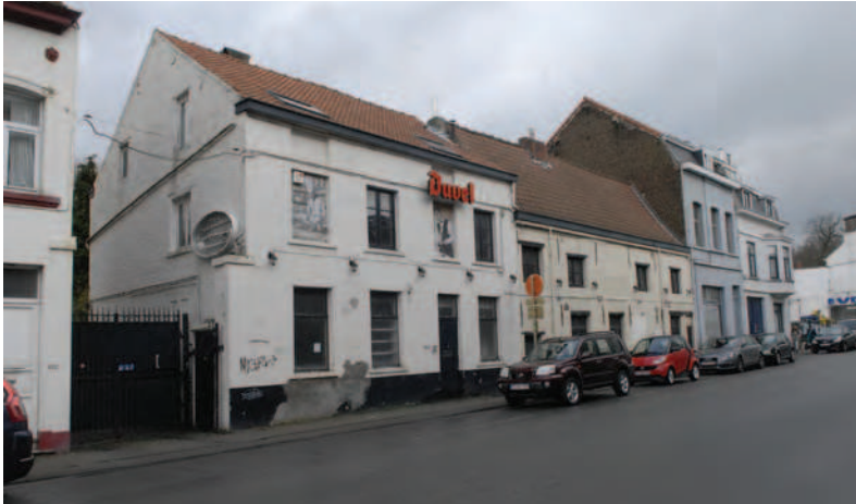
Fig. 1 : Les deux volumes actuels, chaussee de Waterloo 824-830.
