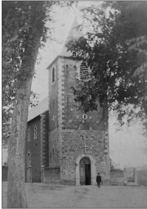
Fig. 3 – La tour occidentale, avant restauration.
