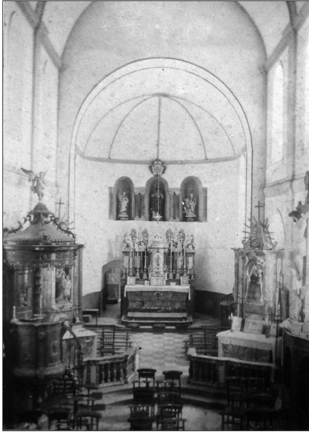
Fig. 4 – Le chœur et la nef, avant restauration. © Archives de la Fabrique d'église.
