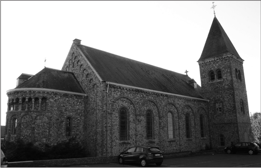
Fig. 13 – La nef, flanc nord, après restauration. © Antoine Baudry.
