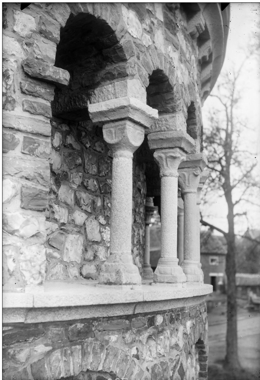
Fig. 17 – La galerie naine, après restauration. © IRPA-KIK, Bruxelles.
