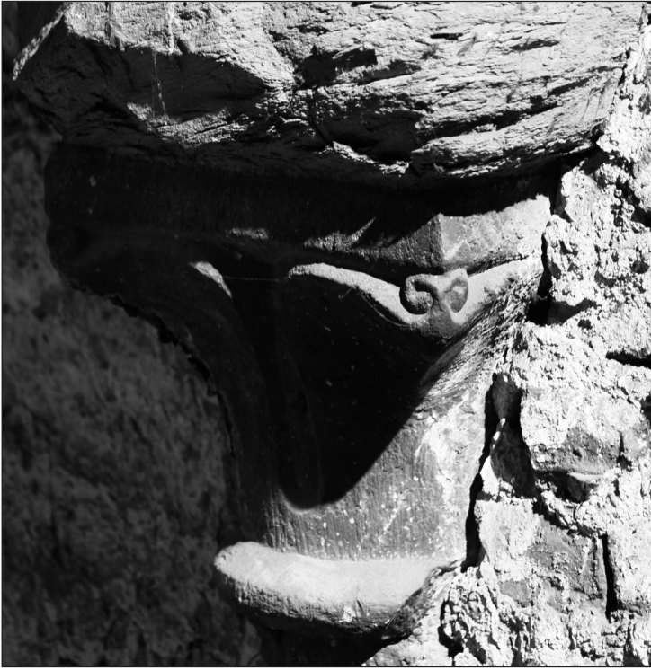
Fig. 18 – Chapiteau de l’octogone du Westbau de Saint-Jacques à Liège. © Antoine Baudry.
