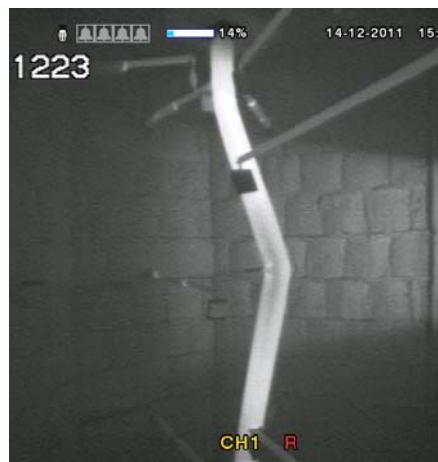
Poteau en acier Steel column
