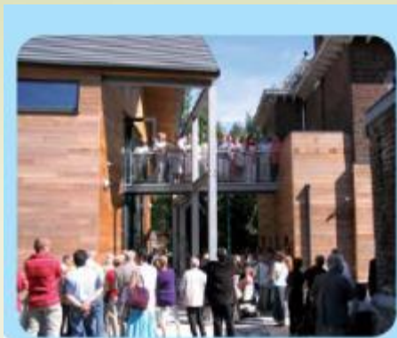
Maison de village de Mellet (Les Bons Villers) – architecte : Bronckart & Jonas FRW, Cahier de la Ruralité n°5, 2004
