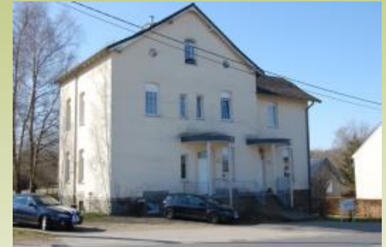
Logement tremplin Waimes CAPRU, 2015
