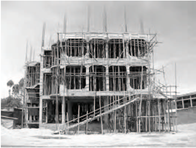
kantoor van handelsvereniging FEC in aanbouw
