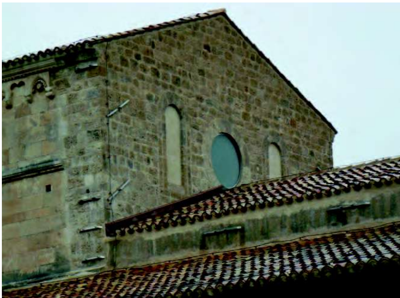
Castiglione a Casauria (PE), San Clemente a Casauria, esterno, lato sud-orientale, timpano dopo l'intervento di risarcimento, Archivio DiSMM, Marrone, 2011.
