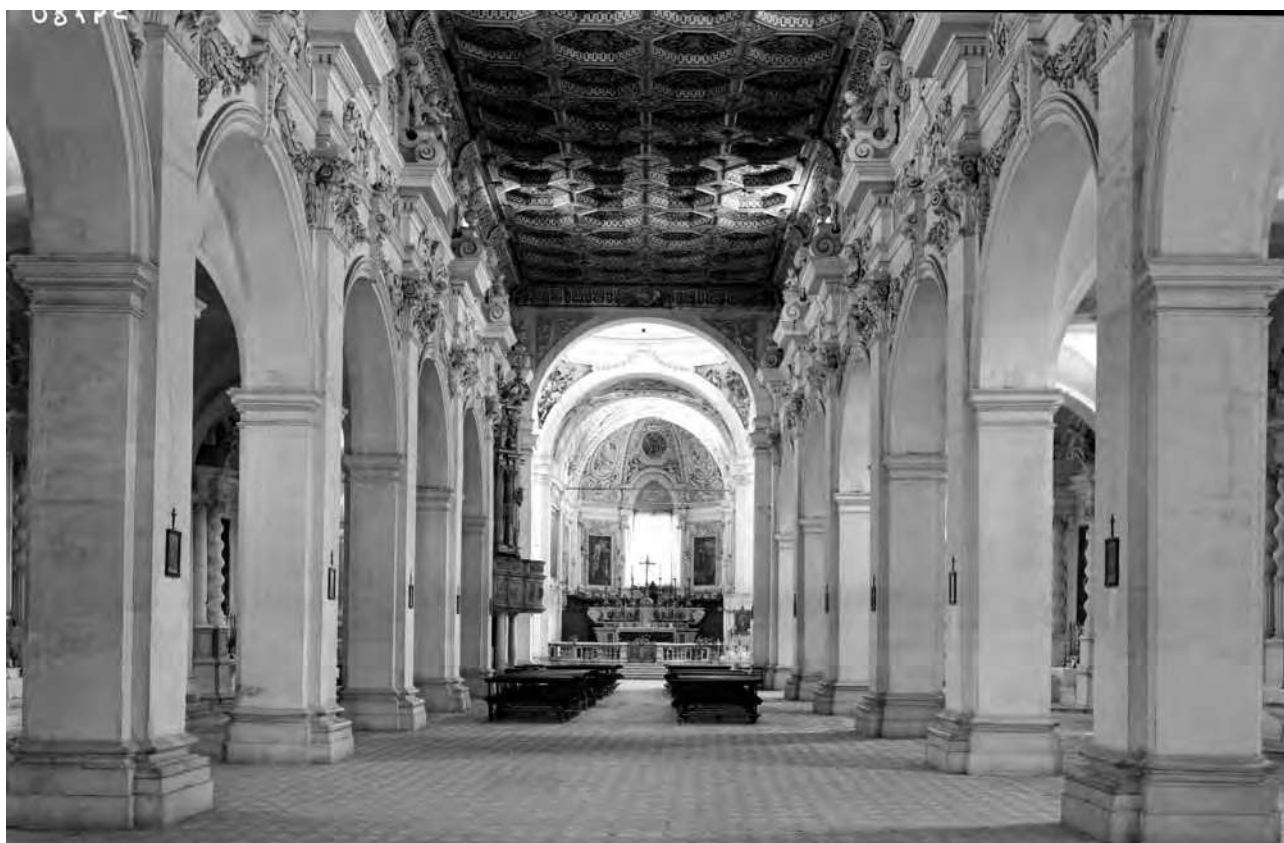
L'Aquila, Santa Maria di Collemaggio, interno prima del restauro di ripristino di Moretti, GFN, 1955.
