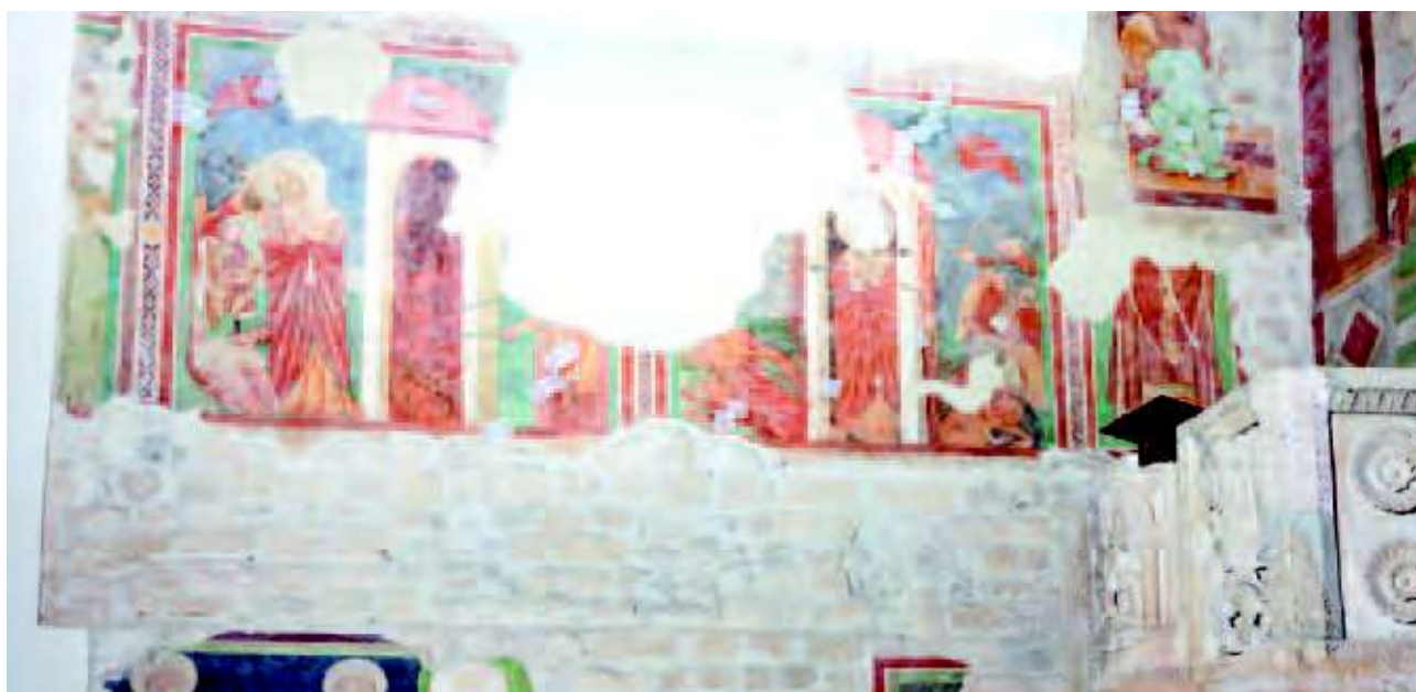
Bazzano (AQ), Santa Giusta di Bazzano, interno, navata centrale, parete settentrionale, affreschi e ambone, Archivio DiSMM, 2010.
