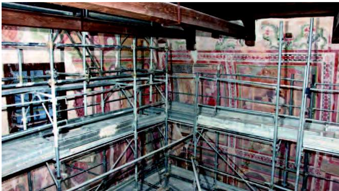
Fossa (AQ), Santa Maria ad Cryptas, interno, veduta della controfacciata e della parete settentrionale, Archivio DiSMM, 2010.
