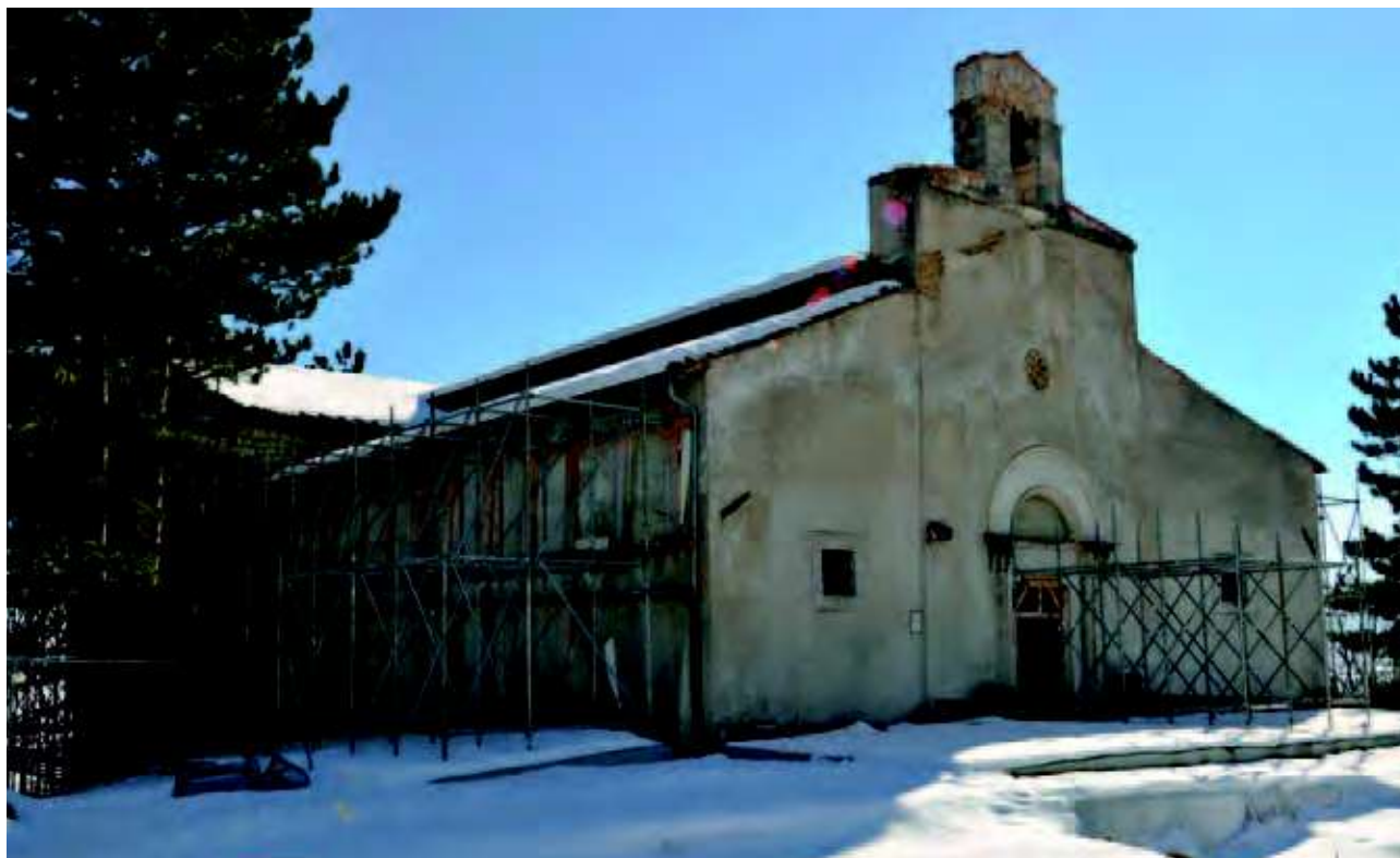
Rocca di Cambio (AQ), Santa Lucia, esterno, veduta nord-occidentale, Archivio DiSMM, 2011.
