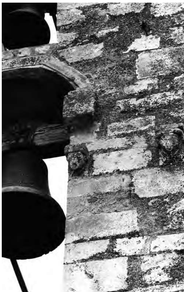
Bazzano (AQ), Santa Giusta di Bazzano, esterno, facciata, campanile, particolare, Archivio DiSMM, Fedeli, 1990.
