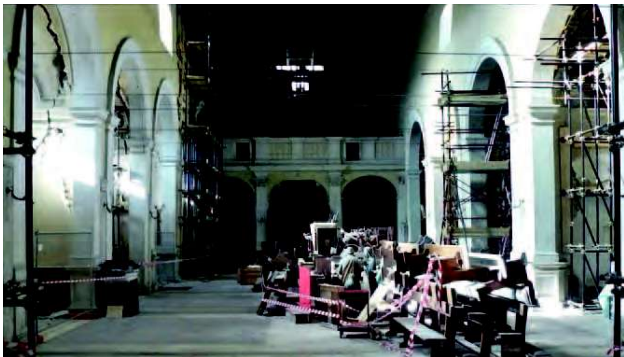
L'Aquila, Santa Giusta di Bazzano, interno, veduta verso la controfacciata, Archivio DiSMM, Fantone, 2010.
