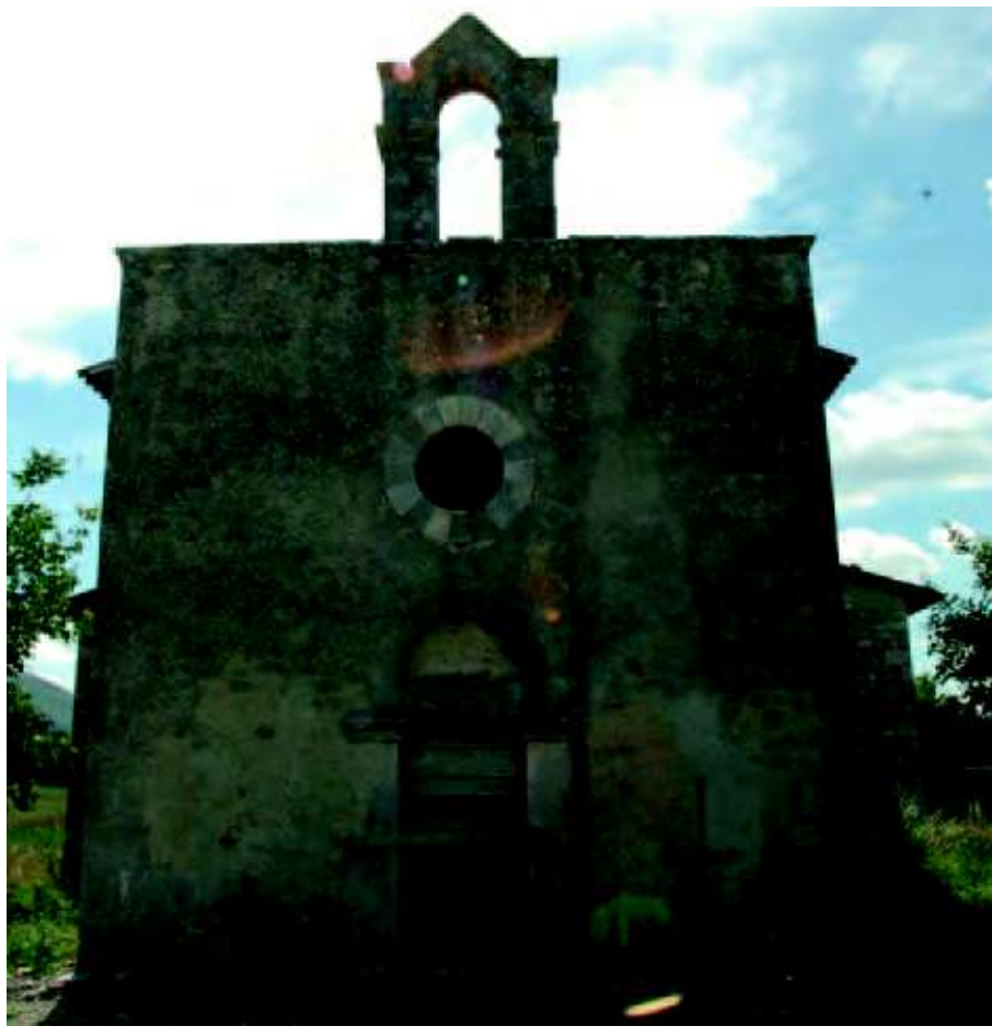
Castelnuovo di San Pio delle Camere (AQ), Santo Stefano, esterno, facciata, Archivio DiSMM, Paone-Tomei, 2006.
