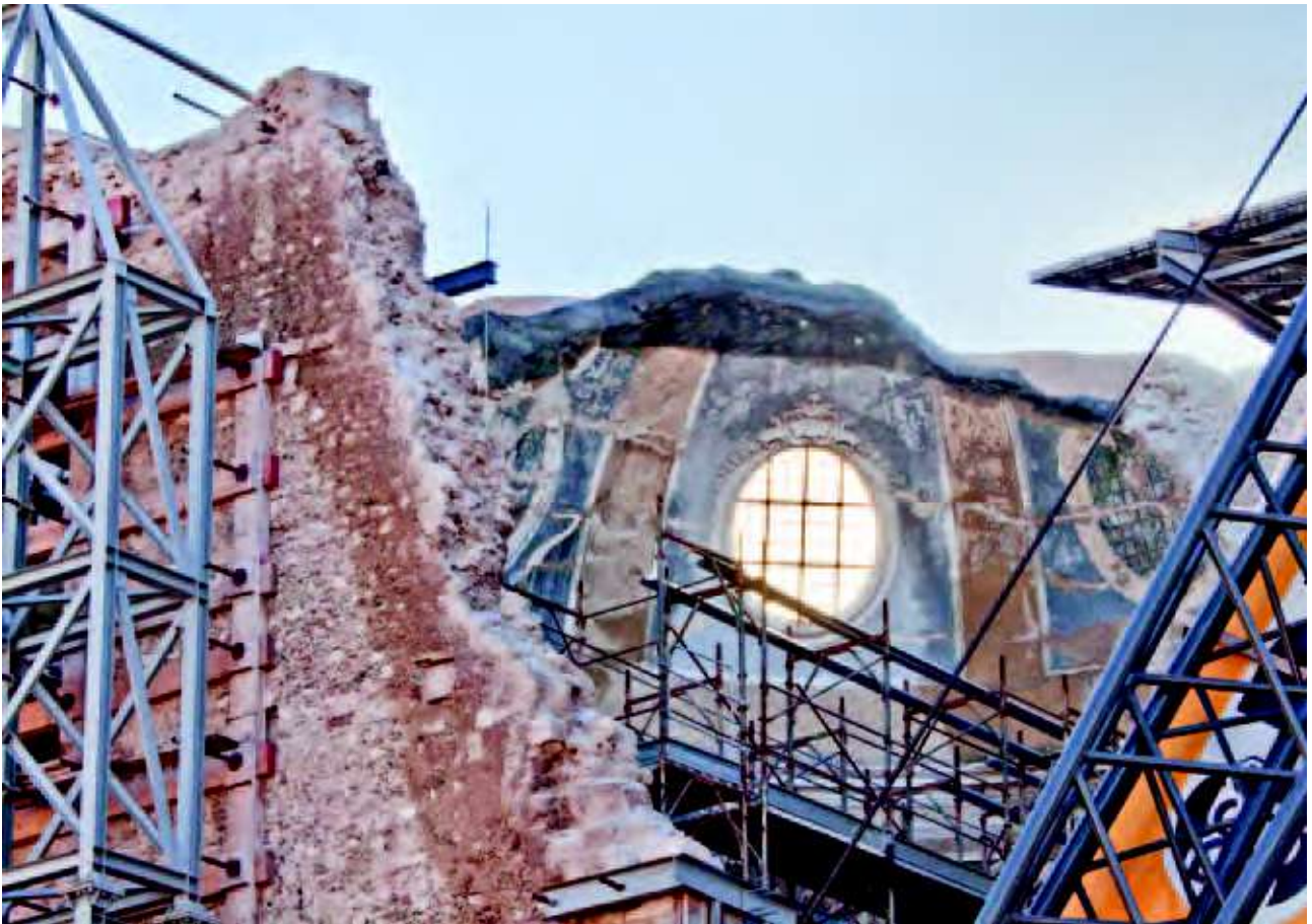
L'Aquila, Santa Maria di Paganica, esterno, lato settentrionale, cupola crollata, Archivio DiSMM, Fantone, 2010.
