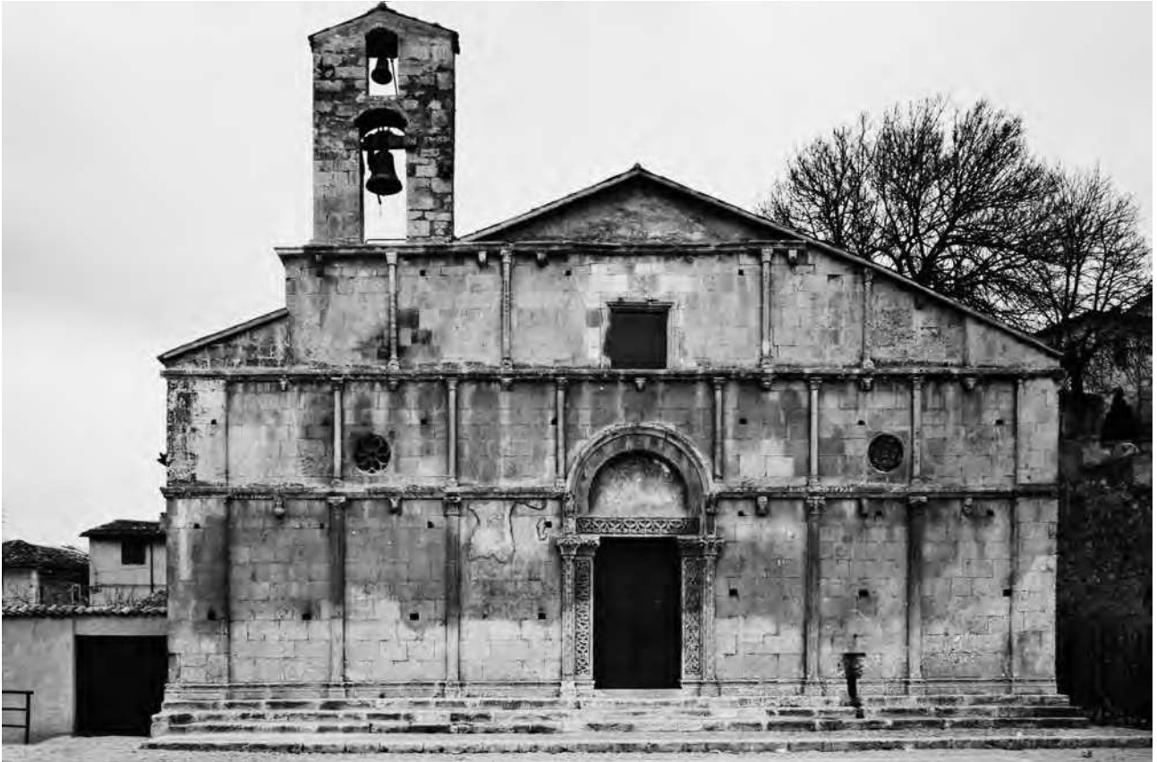
Bazzano (AQ), Santa Giusta di Bazzano, esterno, facciata, Archivio DiSMM, Fedeli, 1990.
