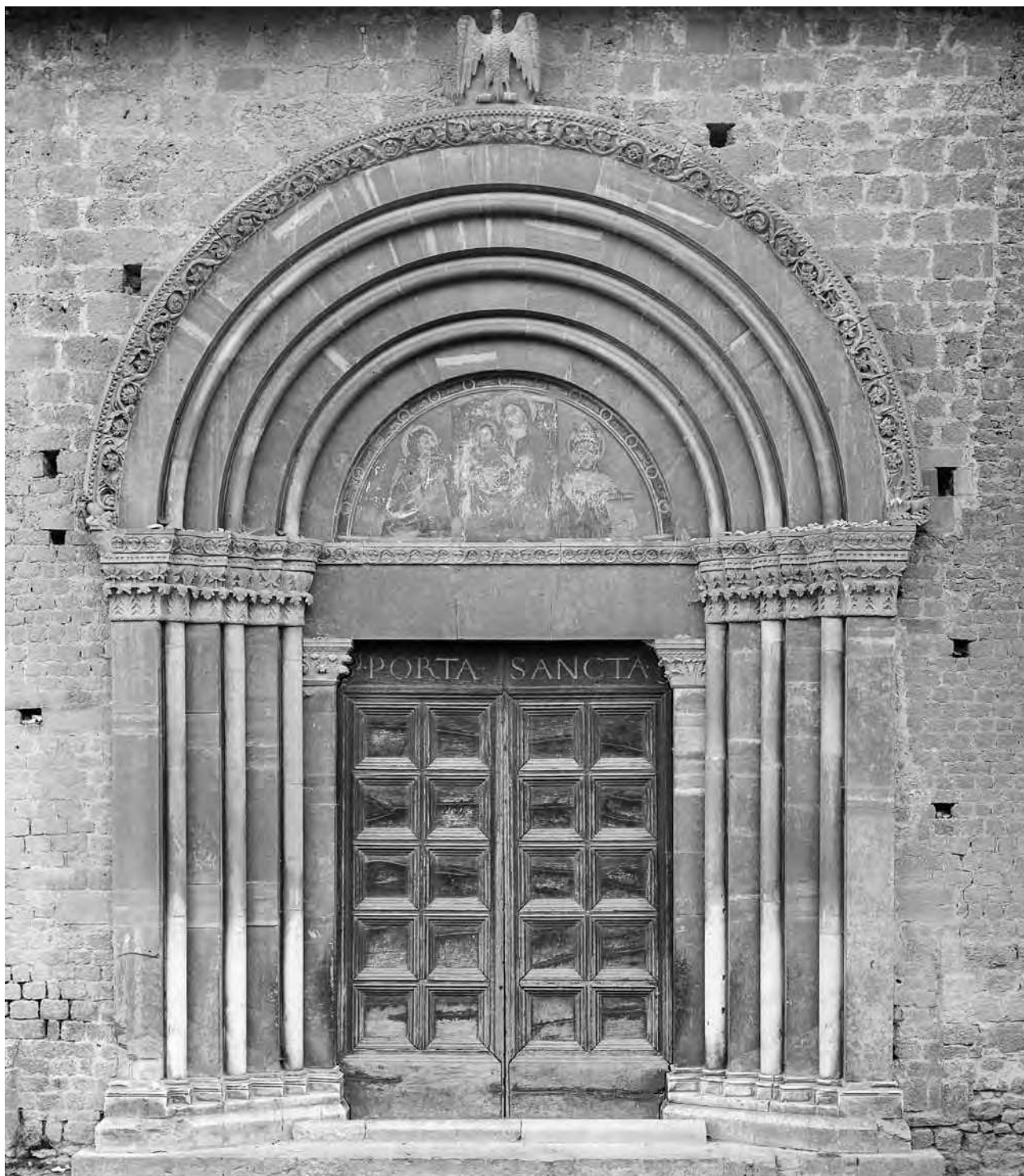
L'Aquila, Santa Maria di Collemaggio, esterno, lato settentrionale, Porta Santa, GFN.
