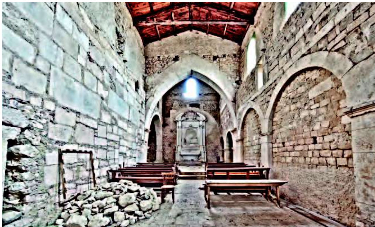
Prata d'Ansidonia (AQ), San Paolo di Peltuinum , interno, Archivio DiSMM, D'Errico, 2010.
