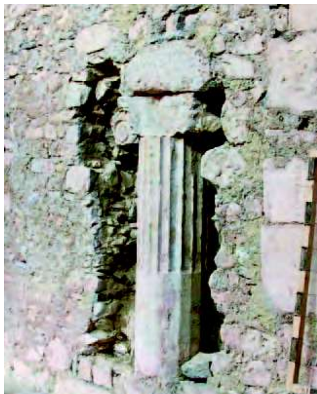
Prata d'Ansidonia (AQ), San Paolo di Peltuinum , interno, parete settentrionale, colonna di reimpiego, Archivio DiSMM, Fantone, 2010.
