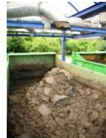
Evacuation des boues déshydratées via conteneurs
