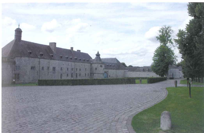
Fig. 2 – Ancienne ferme du château de Modave élevée en moellons de calcaire dinantien. Propriété de Vivaqua, château classé et accessible aux visiteurs (photo E. Goemaere, 2009).
