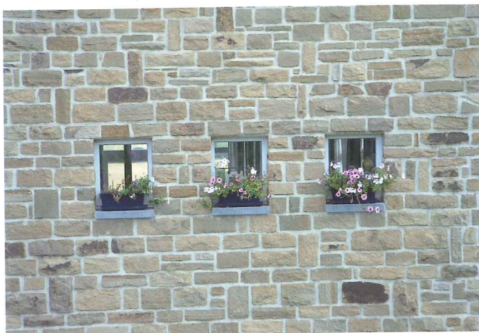
Fig. 22 – Façade de maison contemporaine construite en moellons équarris de grès famenniens, Marchin (photo E. Goemaere, 2009).
