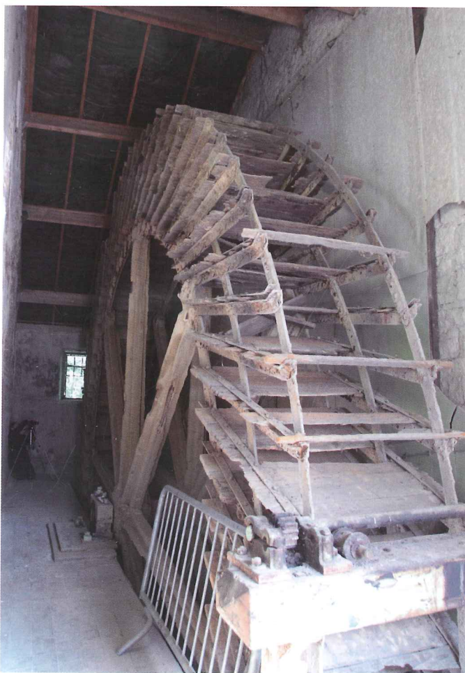
Fig. 1 – Roue à aube de 5,8 m de diamètre, entraînée par le Hoyoux. Elle servait jusque dans les années 1970 à faire remonter les eaux du captage de la CIESAC pour distribuer les eaux sur le plateau (photo G. Michel 2015, CIESAC).
