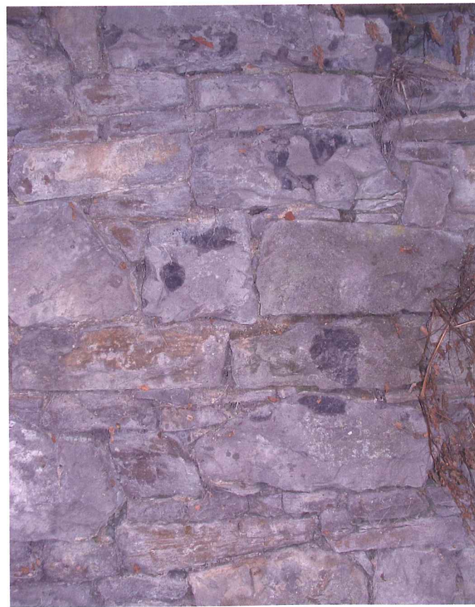
Fig. 17 – Muret de soutènement monté en calcaire tournaisien gris (Formation d'Yvoir ?) à nodules bleu foncé de chert (photo E. Goemaere, 2009).
