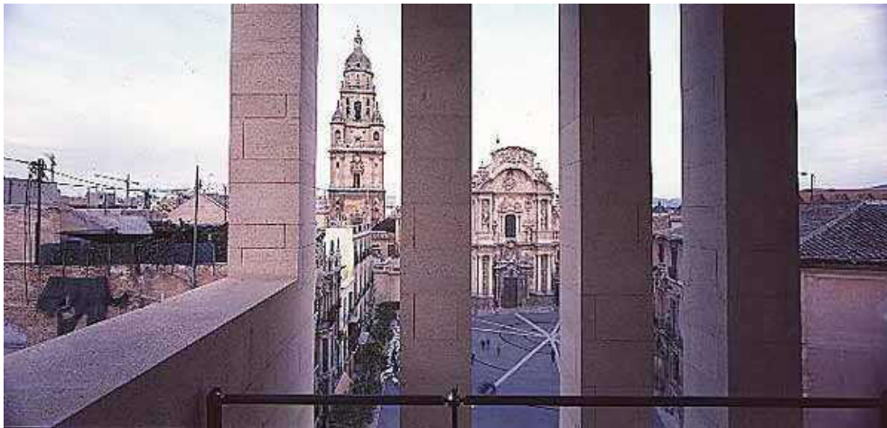
Galerie de l'hôtel de ville de Murcia (Architect : R. Moneo; photo : El Croquis n°98, 1999).
