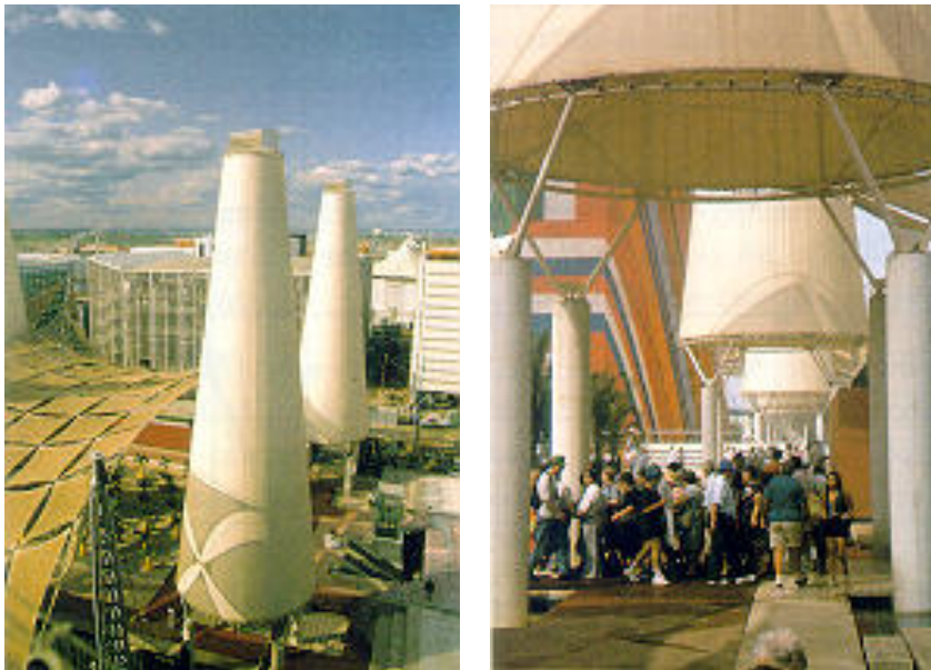
Tours de refroidissement naturel à l'expo'92 de Séville. (Photos : Grupo de termotecnia 1994)
