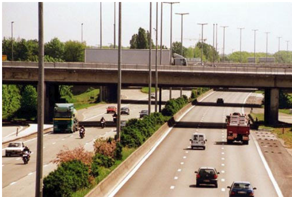
Système autoroutier (Photo : K. De Myttenaere)
