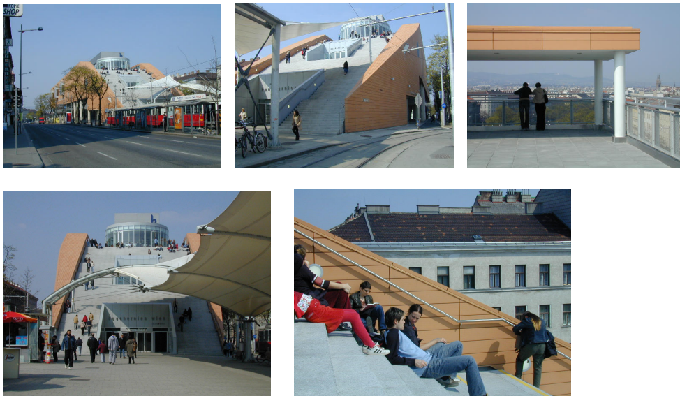
Bibliothèque municipale à Vienne (Photos : K. De Myttenaere)
