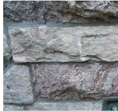
AFBEELDING 28. | Bleek-rose tot rozig grijs gepatineerde bouwstenen uitgevoerd in verschillende variëteiten van Rood marmer van Baelen aan dezelfde plint als in afbeelding 27. Centraal: rode stromatactis-kalksteen, onder en boven: rode “erwtensteen”-variëteit. Foto: P. Elst.
