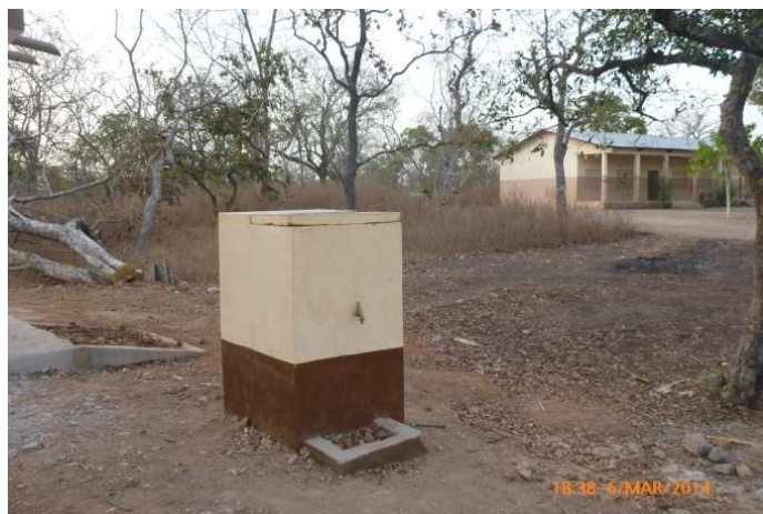
Photo 2. Pompe dans une école de l'arrondissement de Dunkassa.
