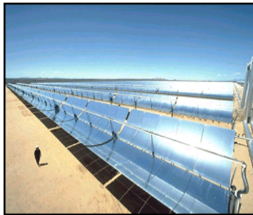
Figure 1.3: Collecteur cylindro-parabolique (SEGS).
