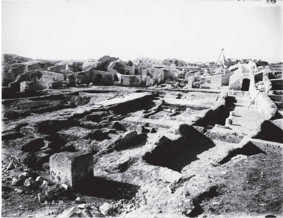
Fig. 3. Le chantier de la « Schola du Trajan », vu de l'arrière-corps, lors des grandes fouilles de l'hiver 1938-1939. Selon les rapports d'activité de ce temps, l'ensemble de cette parcelle urbaine aurait été excavée en moins de six semaines. (photo SBAO n° A2155)
