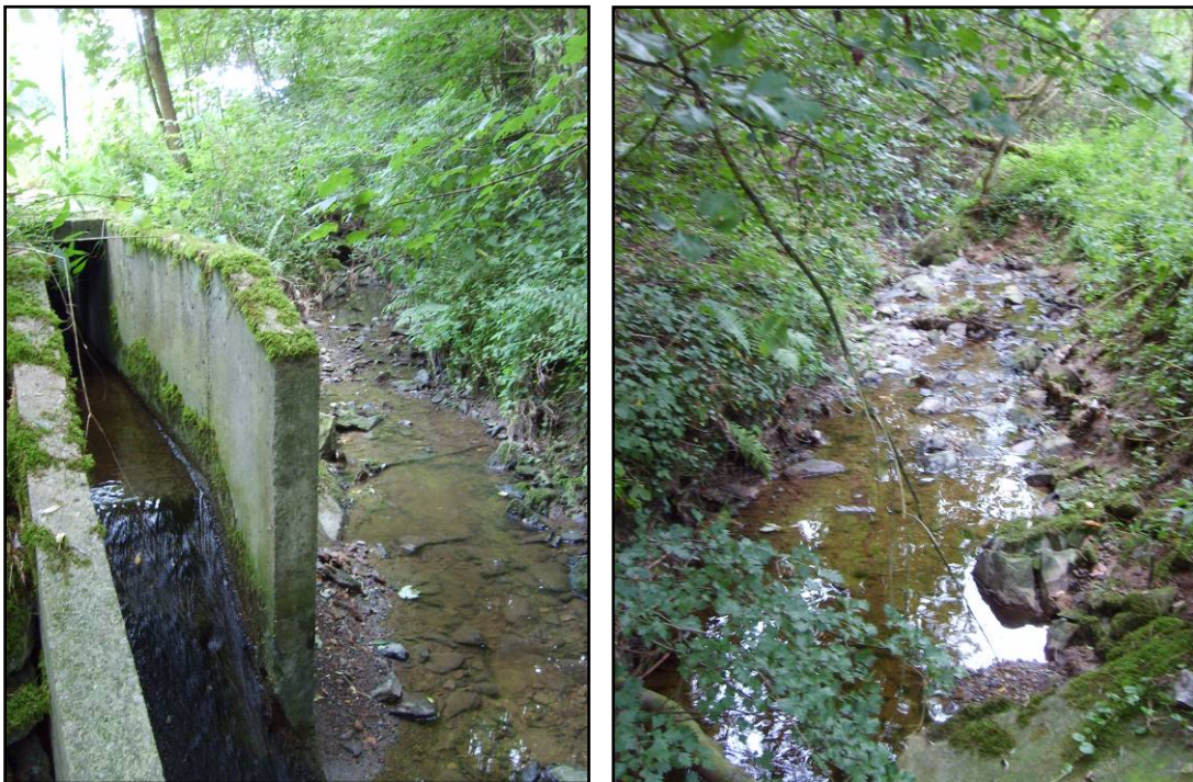
Photo 1 : Rejet de la station d'épuration d'Ouffet
