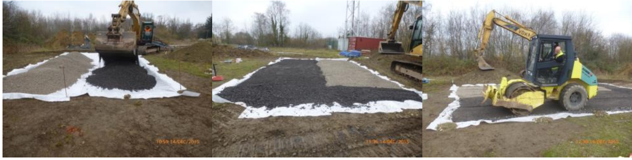
Figure 137 : Mise en œuvre et compactage de la troisième planche d'essai à Quenast.
