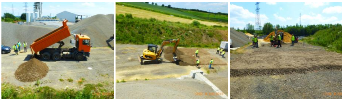
Figure 125 : Mise en œuvre de la seconde planche d'essai.
