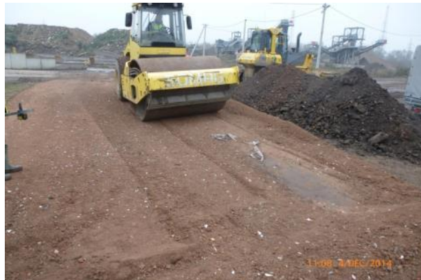
Figure 107 : Compactage de la couche.
