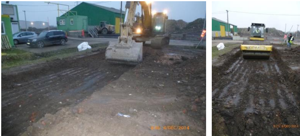
Figure 104 : Préparation du sol-support (terrassement et compactage).
