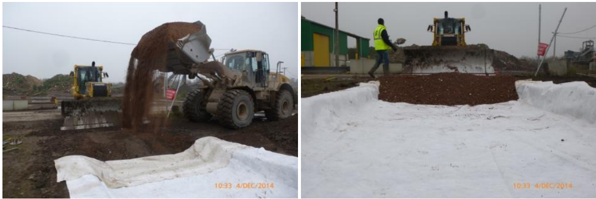
Figure 106 : Mise en œuvre du recyclé 0/31,5.
