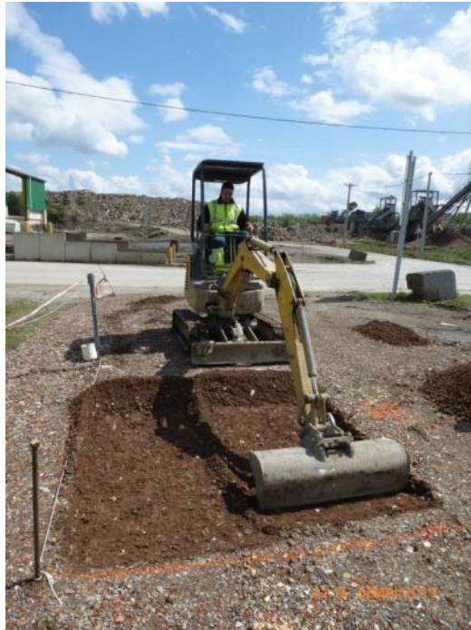
Figure 108 : Démontage partiel de la planche.
