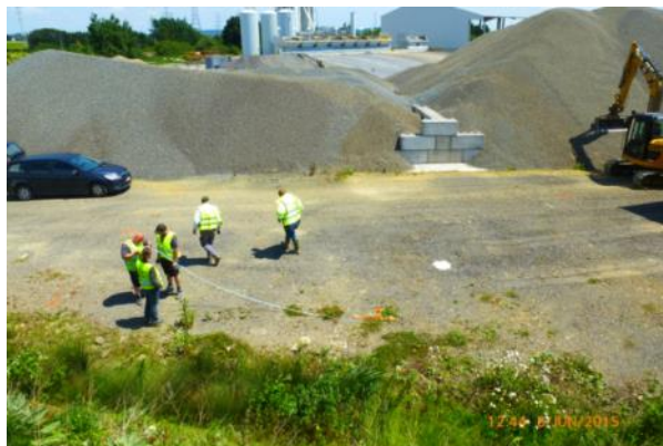
Figure 124 : Site sélectionné pour la planche d'essai concassage/compactage.
