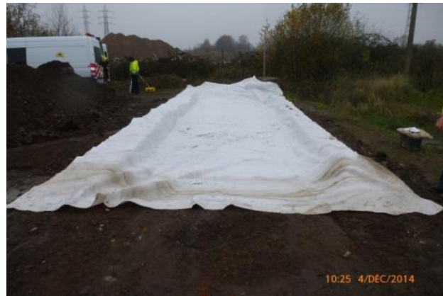
Figure 105 : Pose du géotextile.
