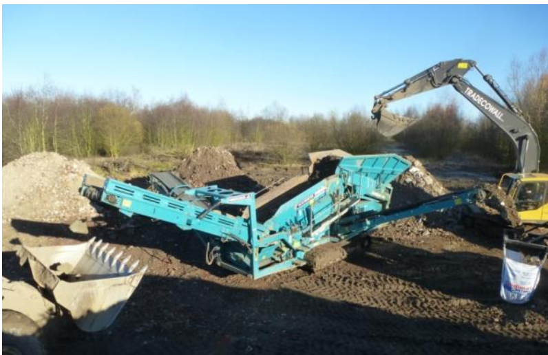
Photo 2 : Mode de prélèvement des déchets bruts par bigbag.
