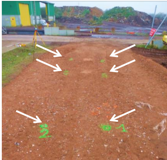
Figure 111 : Positionnement des six repères topographiques sur la planche d'essai.
