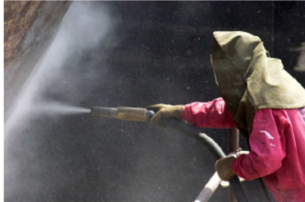
Figure 25 – Sablage de surface en béton.
