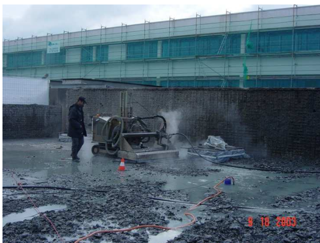
Figure 23 – Machine d'hydrodémolition à plusieurs jets.
