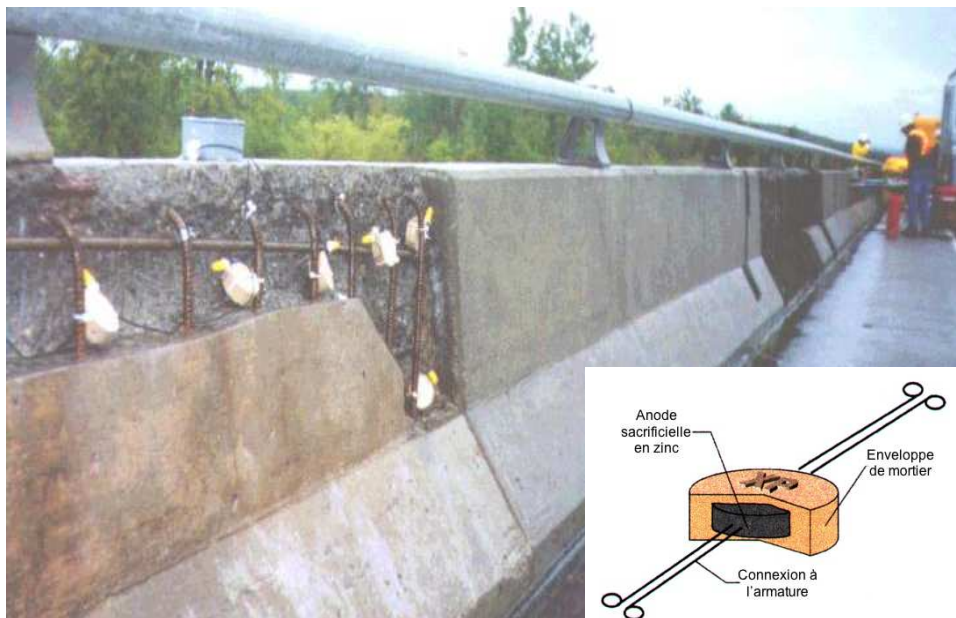
Figure 29 – Installation d'anodes sacrificielles noyées à la périphérie de réparations effectuées sur des parapets en béton.
