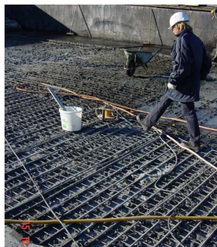
Figure 24 – Etat du béton et des armatures après hydrodémolition.
