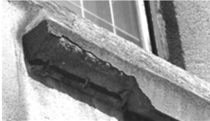
*Epaufures sous un appui de fenêtre*
