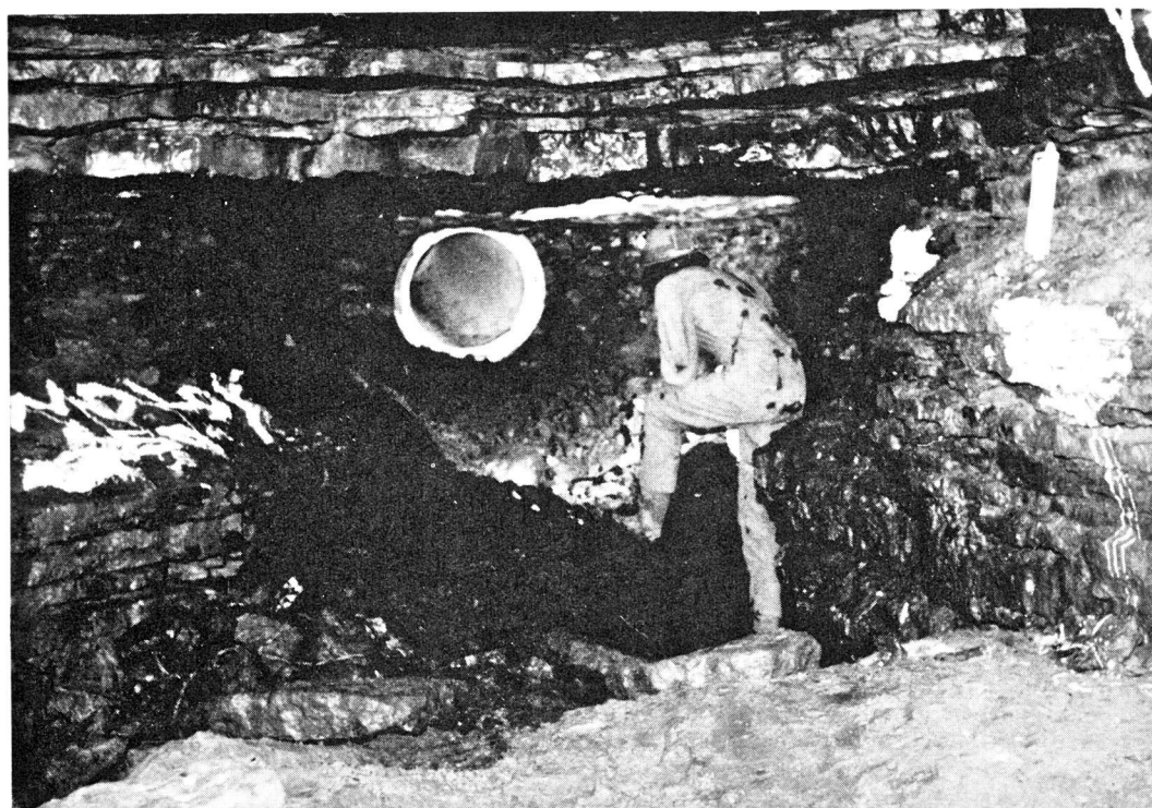
Figure 1. Réouverture de la grotte le 25 avril 1979. Ultimes moments des travaux: un étroit passage va être dégagé, et les premières mesures de CO 2 aussitôt entreprises (haut). Ce puits d'accès a rapidement été remplacé par une tuyauterie de béton. La section subhorizontale du tuyau de béton raccordant le puits d'entrée (tubé, lui aussi) à la salle principale de la grotte (bas). Photos J. Lamarre, S.Q.S.
