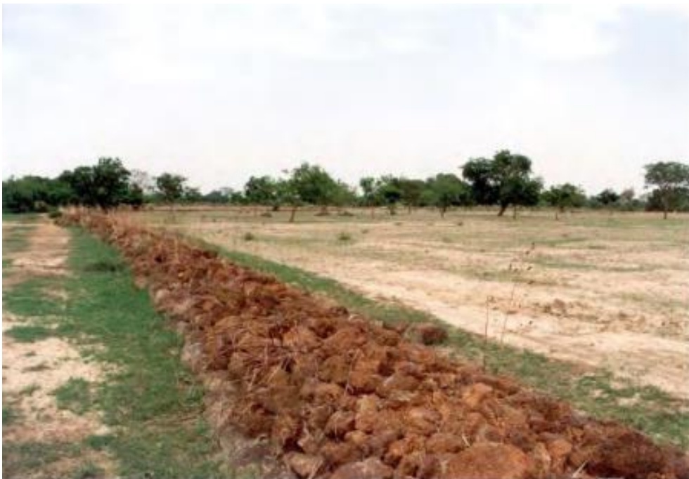
Photo 4. Mise en place de diguettes filtrantes dans une exploitation agricole
