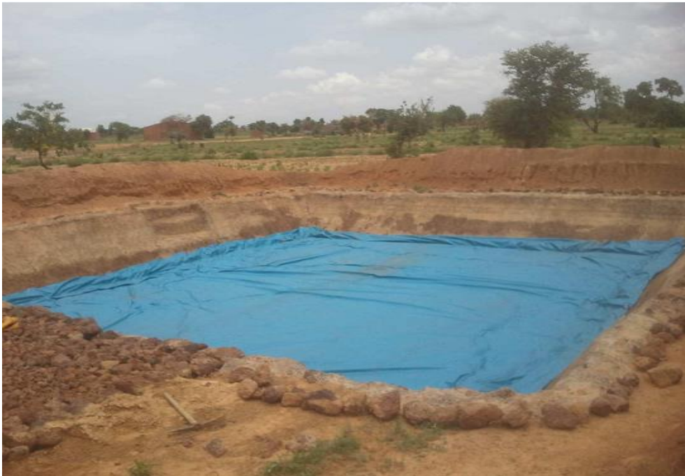
Photo 11. Bassin à fond bâché et parois imperméabilisées en ciment dans le village de Sologom, province du Yatenga en zone sahélienne. Source : Zongo (2014)
