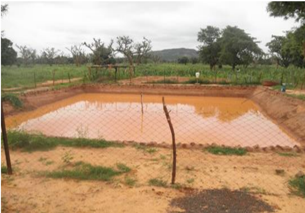
Photo 10. Bassin à fond imperméabilisé en argile et parois imperméabilisées en ciment dans le village de Mogodin, province du Bam en zone sahélienne Source : Zongo (2013)
