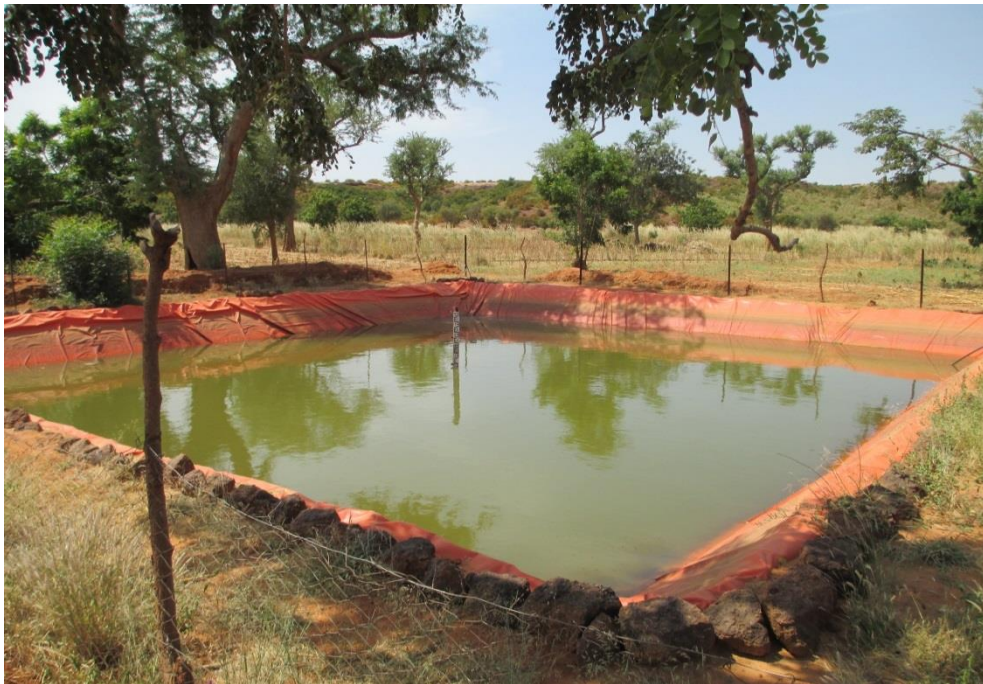
Photo 12. Bassin à fond et parois imperméabilisés à partir d'une bâche sur un sol sableux dans le village de Mogodin, province du Bam en zone sahélienne Source : Zongo (2014)
