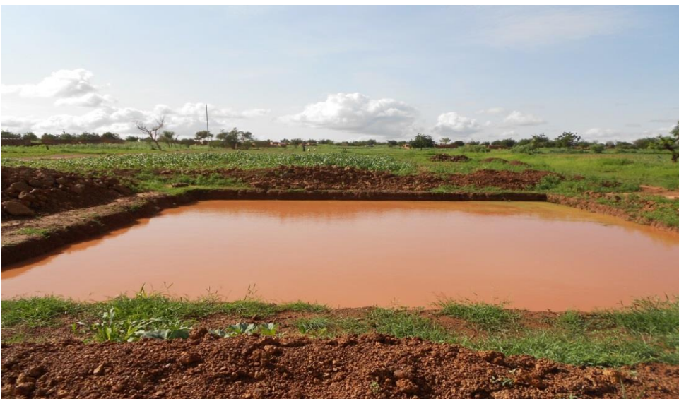
Photo 9. Bassin à fond et parois non imperméabilisés sur un sol latéritique à Tougou, province du Yatenga en zone sahéenne Source : Zongo (2012)
