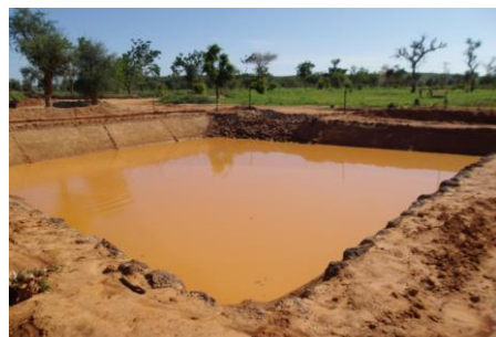
Bassin de collecte d'eau de ruissellement
