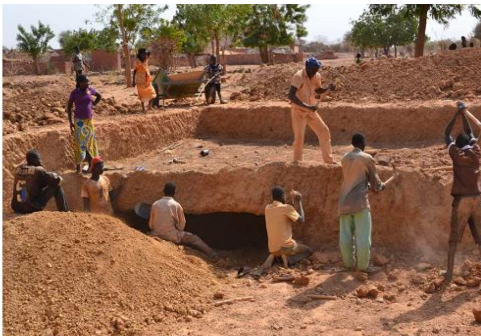
Photo 5. Excavation d'un bassin à partir de la main-d'œuvre familiale Source : Zongo (2012)
