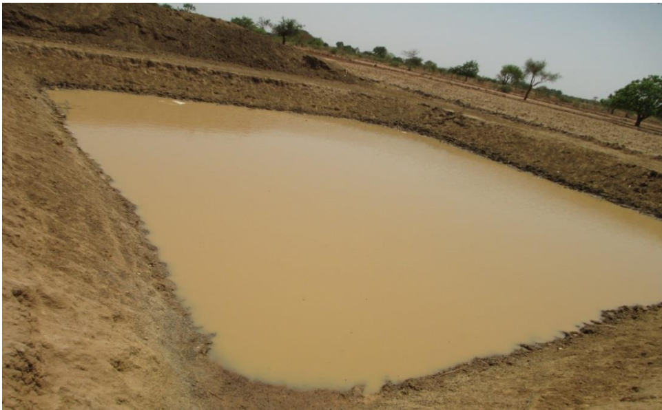
Photo 8. Bassin à fond et parois non imperméabilisés sur un sol argileux dans le village de Sandouré, province du Bam en zone sahéenne Source : Zongo (2012)
