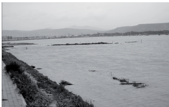
Figure 11. Le remblai de la NSTS empêche l'écoulement des eaux et prolonge la durée des inondations de la plaine littorale.
