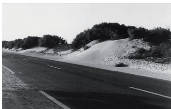
Figure 9. Le tronçon de la route qui assurait la liaison entre l'embouchure de la Moulouya et la ville de Saïdia et le cordon dunaire qui la séparait de la plage. L'élargissement de la route a provoqué l'arasement des dunes bordières, ce qui a favorisé leur mobilité et l'ensablement de la route à cet endroit.
