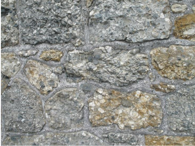
Fig. 14. Mur en conglomérat de Marchin.
