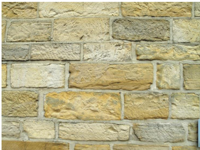
Fig. 34. Mur en grès famennien du Condroz (Formation de Montfort).
