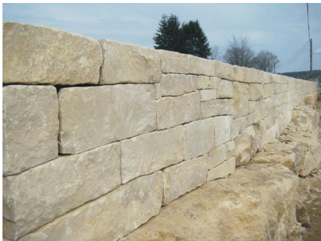
Fig. 49. Mur en Pierre de Fontenoille.
