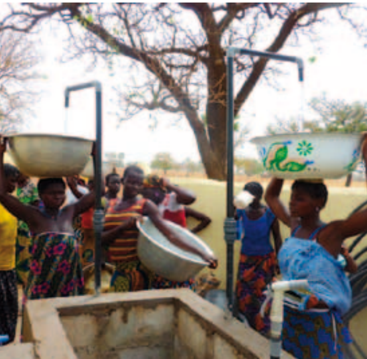
Dans le bourg d'Ogaro (Togo), une station de pompage solaire.
