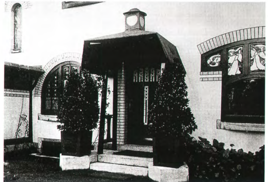
8. La villa L'Aube, Liège. Façade nord. Auvent et porte d'entrée. Photo publiée en 1908.
