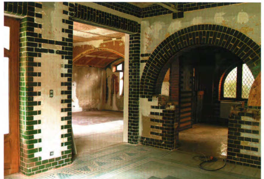
10. Le rez-de-chaussée en cours de restauration. Perspective générale, depuis la salle à manger, avec l'ouverture sur le hall, le salon et le coin à musique. 2008.
