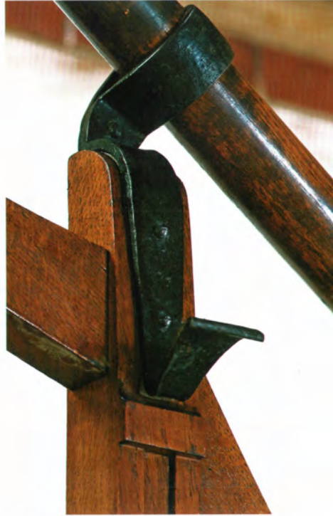
18. Escalier. Détail du raccord de la main-courante au support. 2008.
