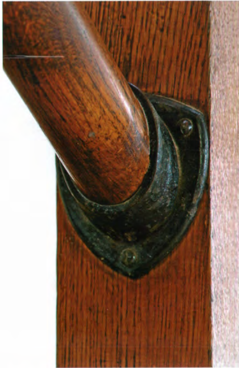
17. Escalier. Détail du raccord de la main-courante au poteau d'angle. 2008.
