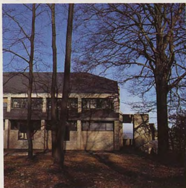
Fenêtre de la Station expérimentale
