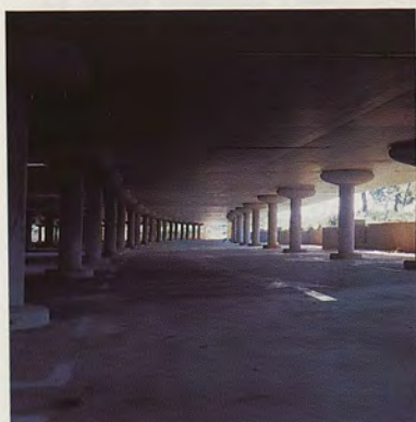
Galerie de liaison entre le Restaurant et les Grands Amphithéâtres
