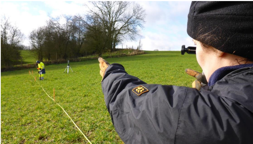
Positionnement d'une fascine perpendiculairement à la pente au moyen du niveau laser.
