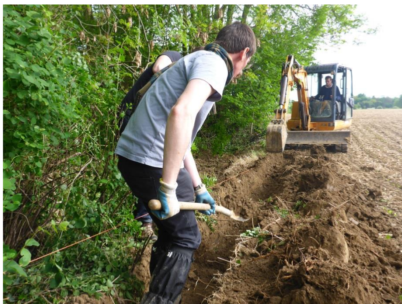
Creusement de la tranchée destinée à recevoir une fascine.
