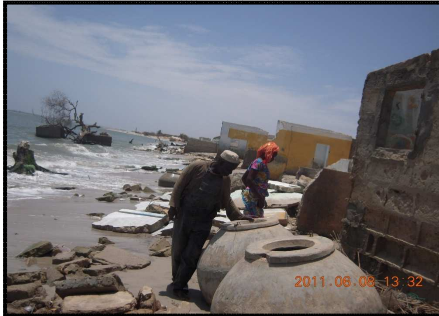
Photo1 : Destruction de maisons à Doun Baba Dièye sous l'effet des vagues (Source : DREEC, 2012)
