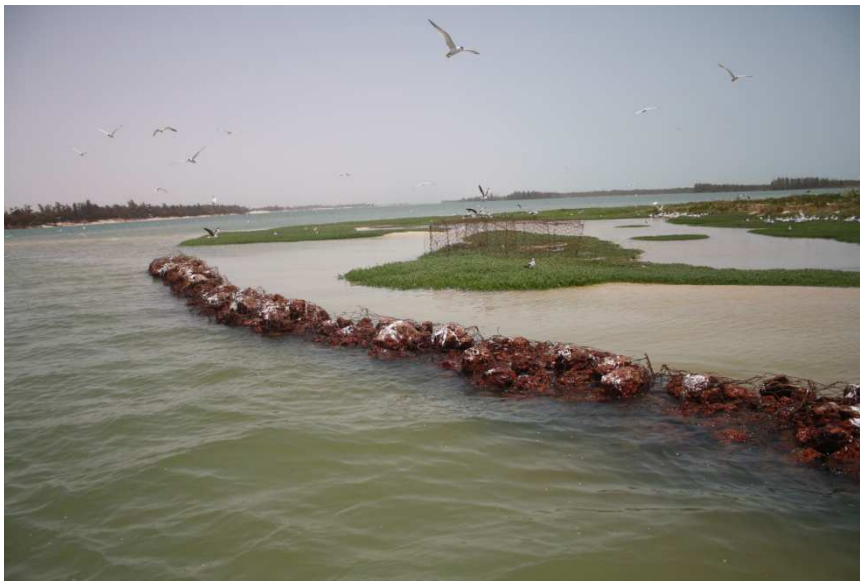
Photo 2: l'Îlot aux oiseaux du PNBL menacée par l'érosion marine malgré un système d'enrochement ( Source : A. Seck, 2013 )
