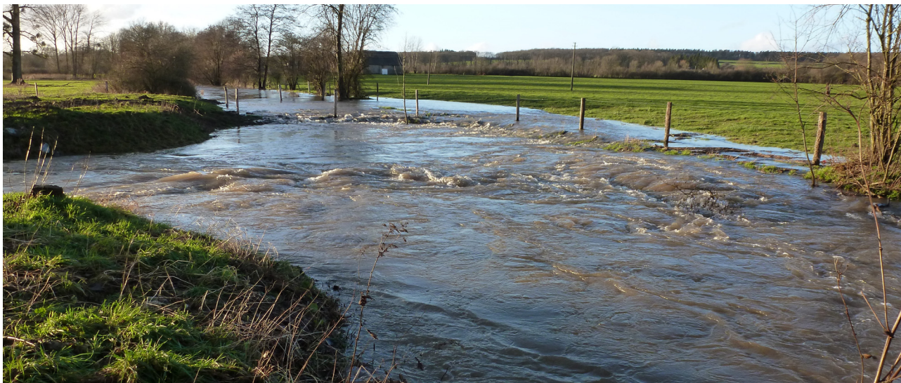
Photo 9: Coupure sèche, fonctionnant en crue (vue vers l'amont, le 30/01/2013)
