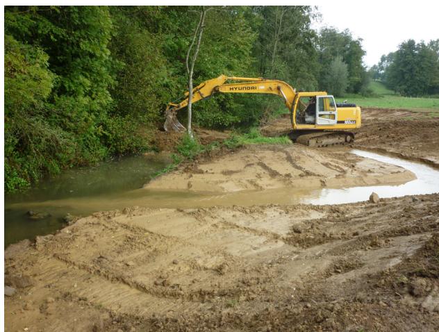
Photo 3: Terrassement du lit (vue vers l'amont)
