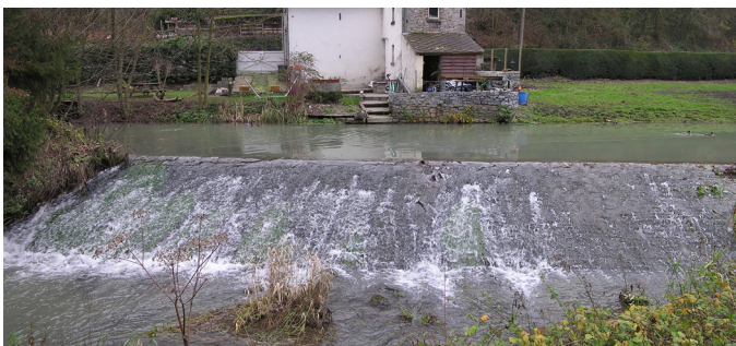
Photo 1: Déversoir de l'ancienne forge Aminthe à Yvoir (h = 1,48 m)
