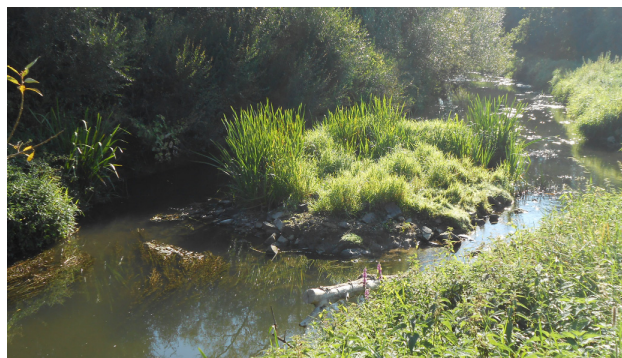
Photo 8: Création d'un îlot dans un secteur à faible enjeu d'inondation (vue vers l'amont)
