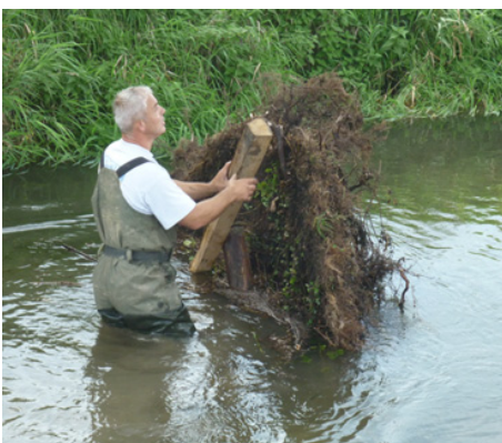
Photo 11: Fixation d'un tronc avec souche au moyen de pieux croisés
