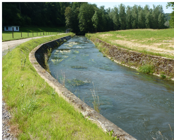
Photo 9: Diguette enherbée en rive gauche (vue vers l'aval)
