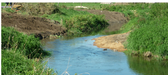
Photo 5: Défecteur en terre recouvert par un géotextile de coco accentuant la sinuosité (vue vers l'amont)
