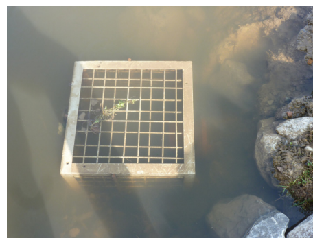
Photo 8: Prise d'eau de l'orifice noyé
