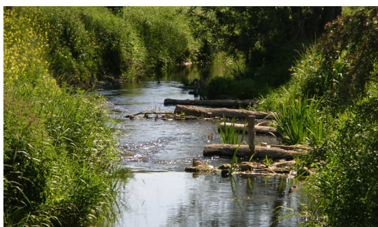
Photo 4: Troncs déflecteurs posés en oblique par rapport à l'axe d'écoulement (vue vers aval)
