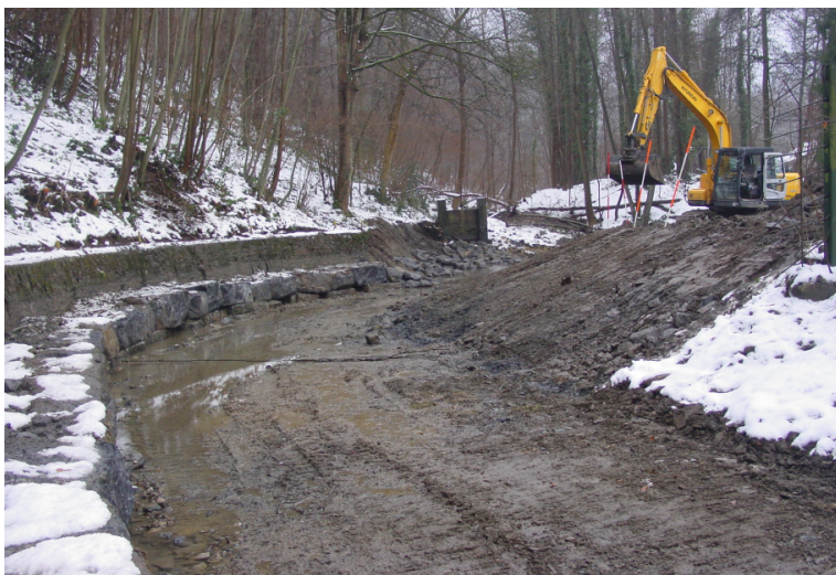
Photo 5: Lit retaluté et enrochements protégeant la berge gauche
