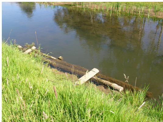
Photo 6: Troncs d'arbres disposés en sous berge (10 mois après les travaux)
