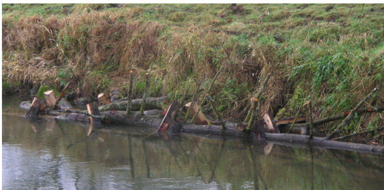
Photo 16: Sous-berge en troncs couchés
