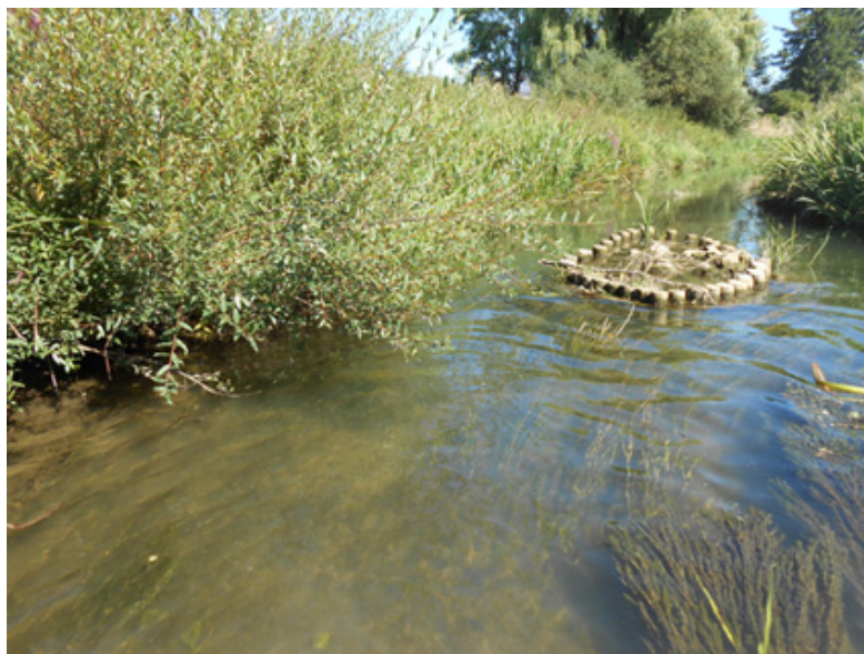
Photo 14: Îlot et plantations de saules ( Salix purpurea ) formant une ripisylve de contact et une zone de refuge pour les poissons (vue vers l'aval)
