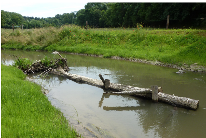
Photo 18: Sous-berge en troncs couchés
