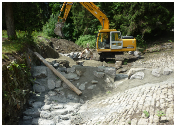
Photo 5: Construction des pré-barrages au moyen d'enrochements liaisonnés au béton
