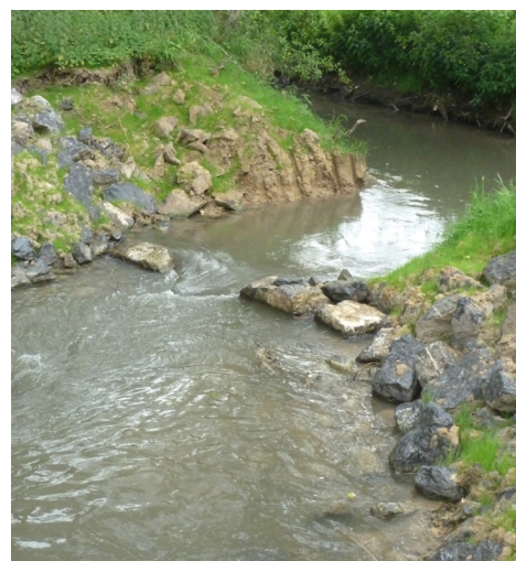
Photo 6: Seuil d'entrée de la rivière de contournement (vue vers l'amont)
