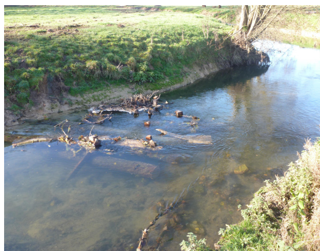
Photo 22: Amas de bois faisant office de déflecteur (vue vers l'aval)
