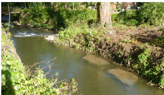
Photo 8: Dalles offrant des caches pour poissons dans le secteur aval du dispositif (vue vers l'aval)
