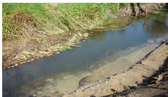
Photo 7: Risbermes terrassées en déblai sur les deux rives (vue vers l'amont ; les cordons d'hélophytes marquent l'ancien pied de berge)
