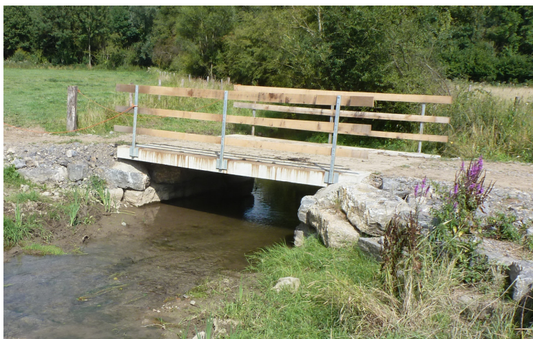
Photo 11: Passerelle pour charroi agricole
