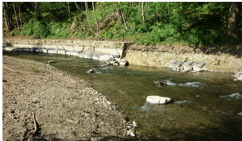
Photo 7: Berge droite retalutée et épis en enrochements au pied de la berge gauche. Mur de berge gauche à l'arrière plan (vue vers l'amont, 2 mois après les travaux)
