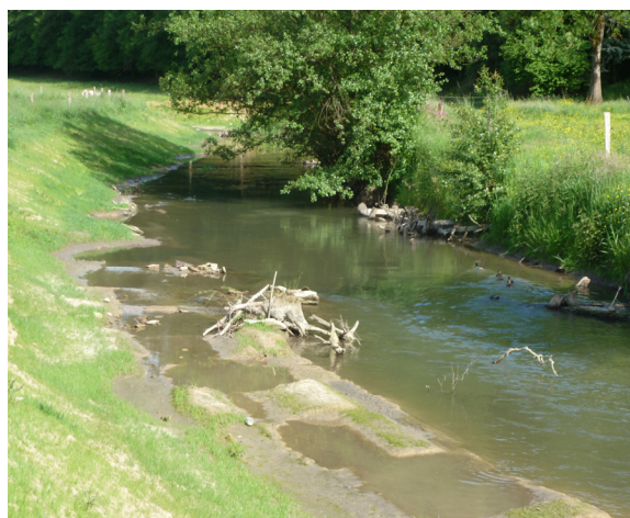
Photo 11 : Terrassement des berges et risbermes (10/2012, vue vers l'amont)
