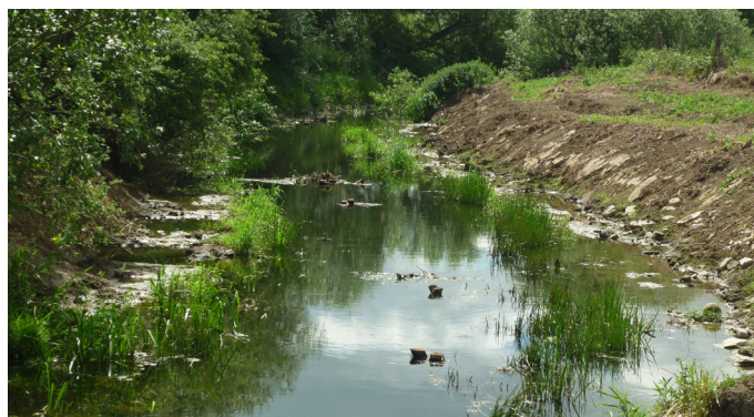
Photo 7: Risbermes terrassées en déblai sur les deux rives (vue vers l'amont ; les cordons d'hélophytes marquent l'ancien pied de berge)
