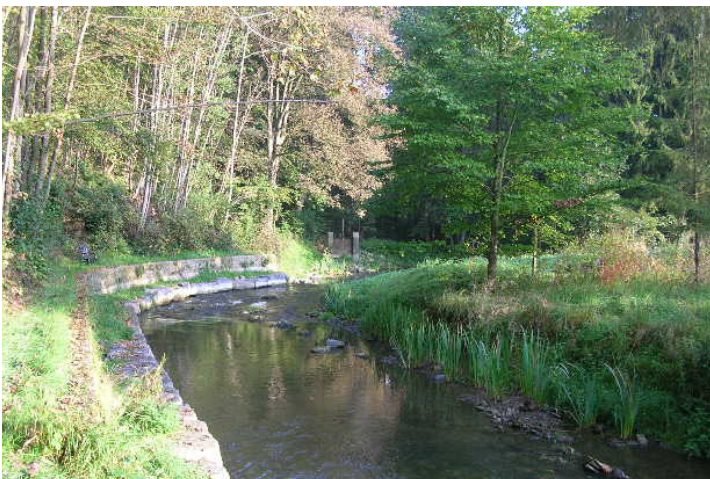
Photo 9: Mur de berge gauche et plantation d'hélophytes au pied de la berge droite (vue vers l'aval, 10 mois après les travaux)
