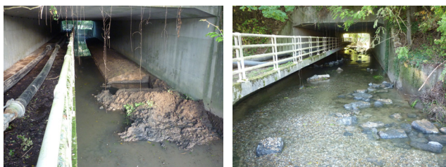
Photos 9 et 10: Pertuis en cours d'aménagement (à gauche) et juste après les travaux de réhabilitation (à droite) (vue vers l'aval)
