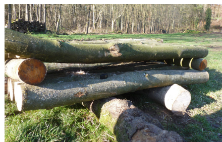
Photo 17: Assemblage de rondins de bois à disposer en sous-berge
