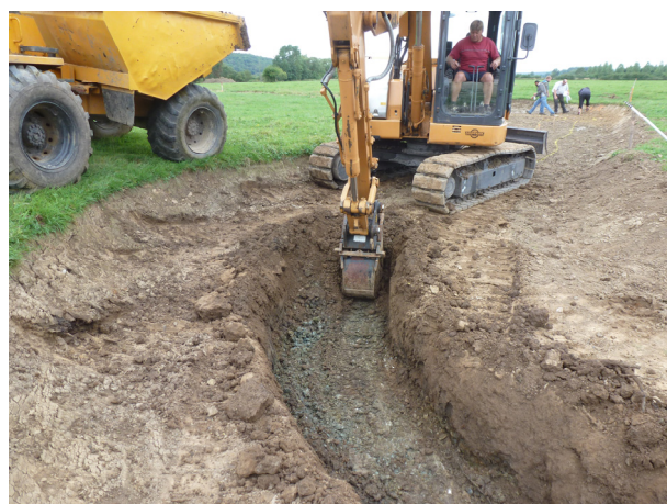
Photo 6: Déblai du chenal d'étiage
