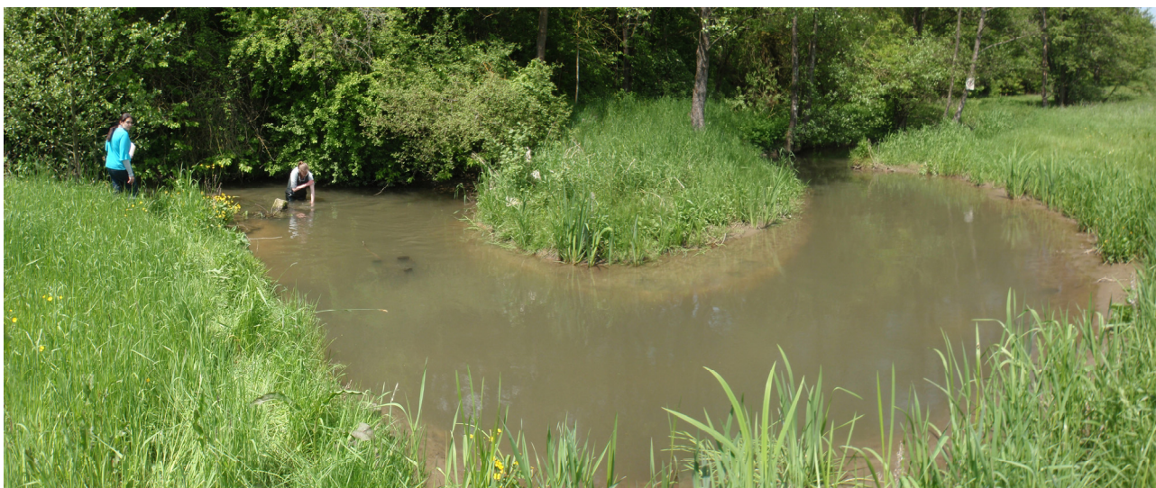
Photo 11: Méandre amont (vue vers l'amont prise 1,5 ans après les travaux)
