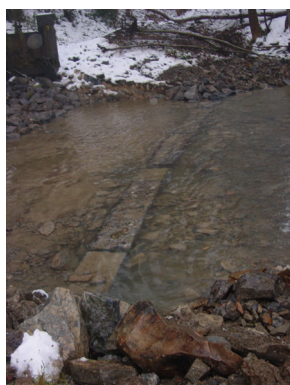
Photo 6: Seuil de fond en enrochements au droit de l'ancien barrage
