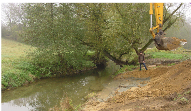
Photo 10 : Terrassement des berges et risbermes (10/2012, vue vers l'amont)
