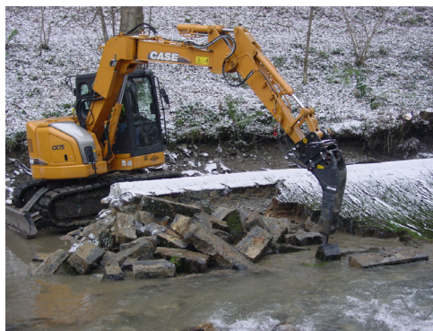
Photo 3: Démolition de l'ouvrage
