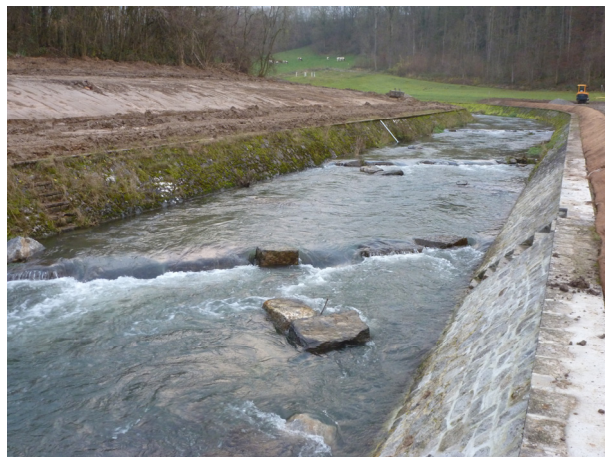
Photo 5: Blocs disposés à l'aval de l'échancrure du seuil (vue vers l'amont)
