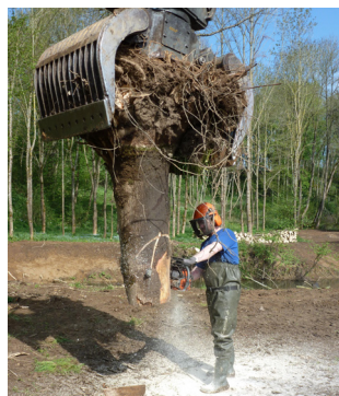
Photo 19: Préparation de la souche avant sa mise en place
