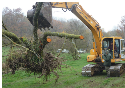
Photo 14 : Transport d'un tronc avec souche sur chantier
