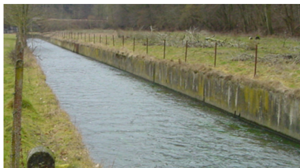
Photo 1: Secteur amont avant travaux de réhabilitation
