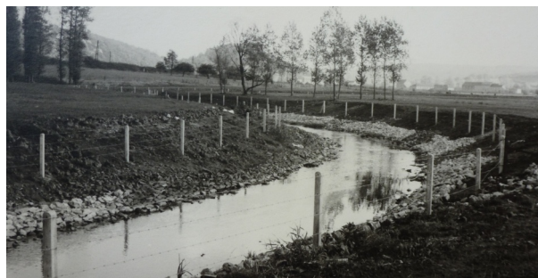
Photo 1: Travaux de rectification sur l'Eau Blanche à Nismes (vue vers l'aval, 1958)
