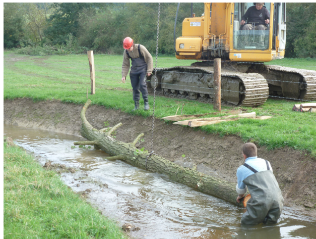
Photo 10: Mise en place de troncs
