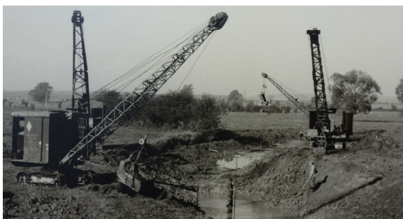
Photo 1: Travaux de rectification en 1954 sur l'Eau Blanche à Mariembourg (Pont Pavot)
