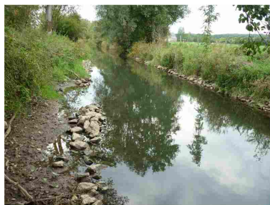
Photo 1: L'Eau Blanche à Boussu-en-Fagne avant les travaux de restauration (vue vers l'amont)
