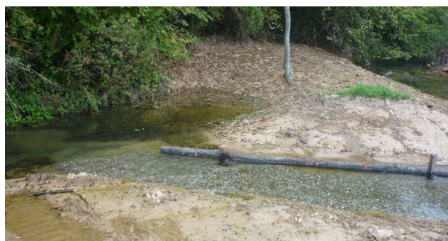
Photo 5: Annexe hydraulique, tronc d'arbre servant de cache à poissons et frayère reconstituée (galets)
