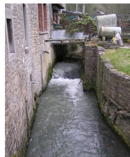
Photo 2: Seuil fixe du bief de l'ancienne forge
