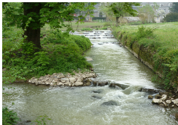
Photo 7: Seuil aval (vue vers l'amont)
