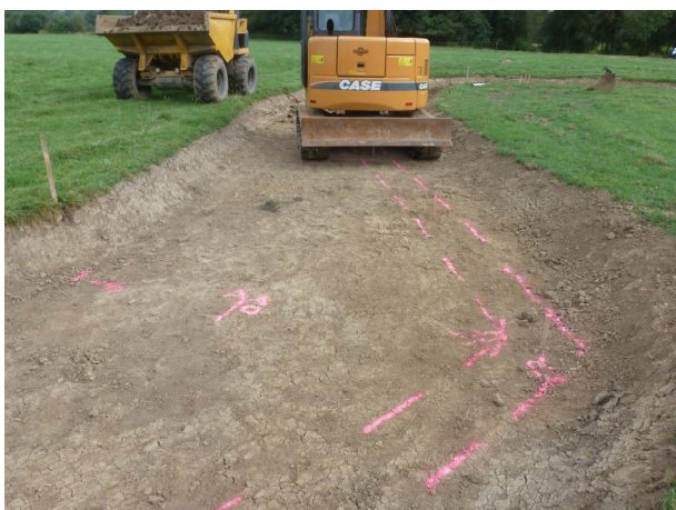
Photo 5: Déblai des banquettes latérales
