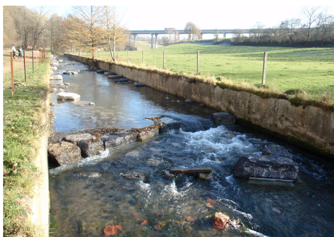
Photo 3: Seuil avec échancrure sur secteur amont (vue vers l'amont)
