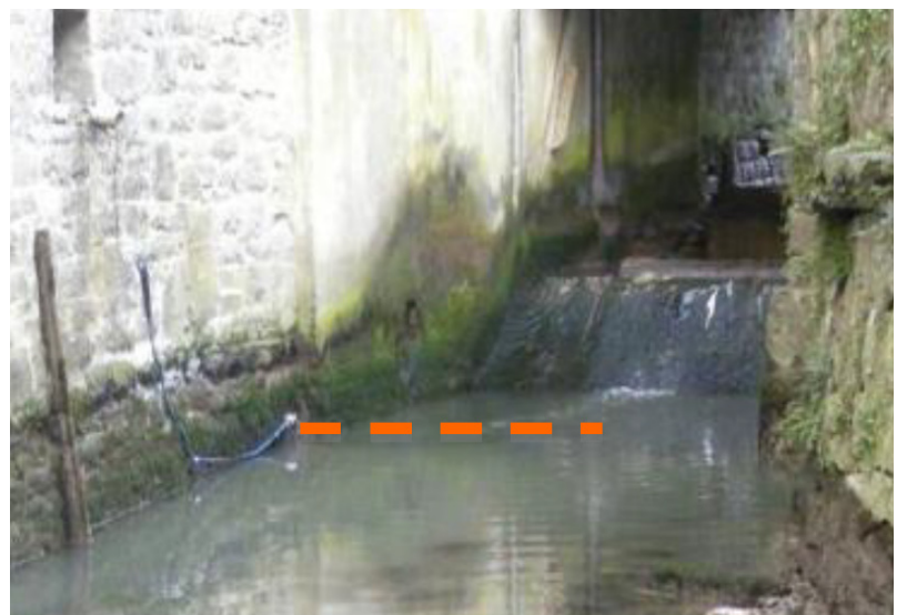
Photo 10: Placement de l'antenne 2 dans le bief, au pied d'un obstacle difficilement franchissable
