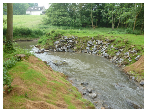
Photo 7: Aménagement des berges au niveau de la sortie de la rivière de contournement (vue vers l'amont)
