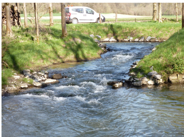
Photo 4: Sortie (aval) de la rivière de contournement (vue vers l'amont)
