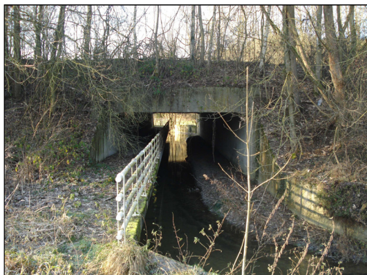
Photo 1: Pertuis avec passage pour bovins en encoffrement
