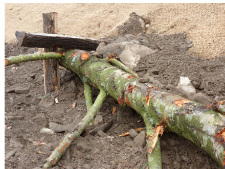
Photo 15: Sous-berge réalisée à sec dans un bras de contournement
