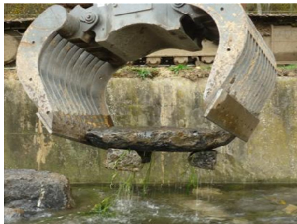
Photo 8: Pose d'une dalle qui servira de cache à poissons
