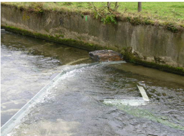
Photo 4: Détail des cornières en acier
