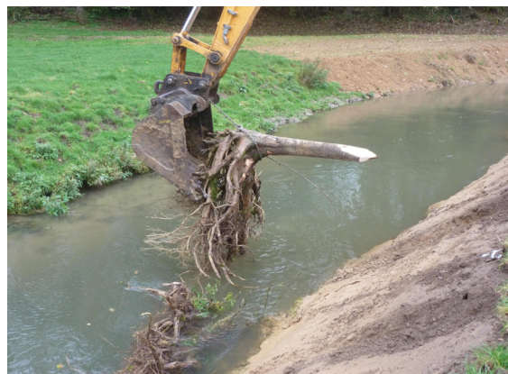
Photo 20: Mise en place de souches d'arbres dans le fond du lit (vue vers l'aval)
