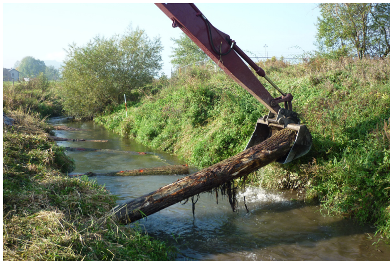
Photo 12: Fixation par ancrage en berge d'un tronc taillé en pointe à l'aide d'une pelle mécanique (vue vers l'amont)
