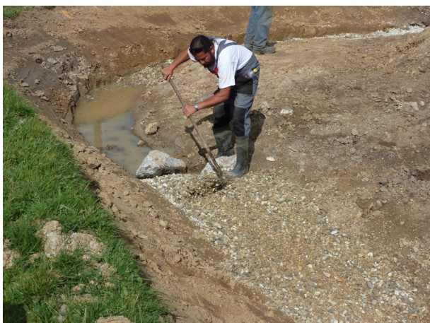
Photo 7: Mise en place du gravier roulé
