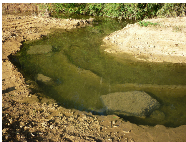
Photo 4: Terrassement du lit sur 2 niveaux et dalles servant de caches à poissons (vue vers l'aval)
