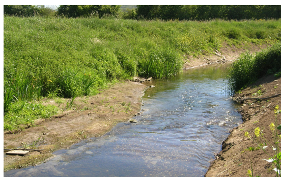
Photo 8: Risbermes terrassées en déblai sur la rive gauche et en remblai sur la rive droite (vue vers l'aval)
