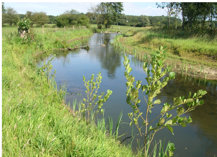
Photo 5: Diversification des habitats dans le méandre (vue vers l'amont, 10 mois après les travaux)
