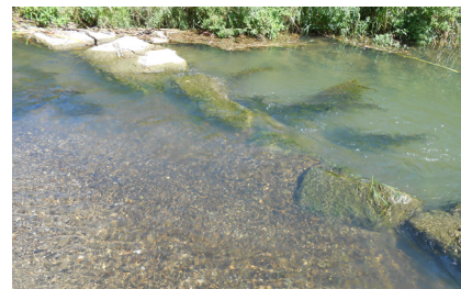
Photo 3: Défecteur oblique en enrochements, piégeant des graviers en amont
