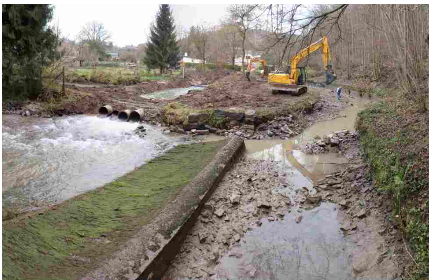
Photo 4: Mise à sec du lit et dérivation provisoire du Bocq
