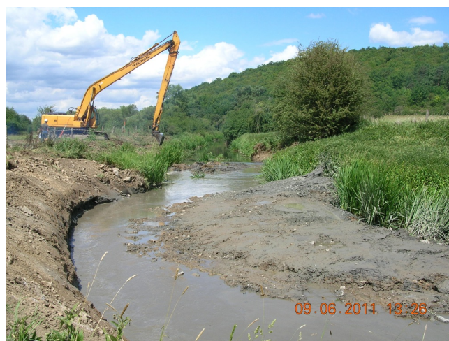
Photo 3: Terrassement des nouveaux méandres en déblai remblai et création d'un dépôt émergé (vue vers l'amont)
