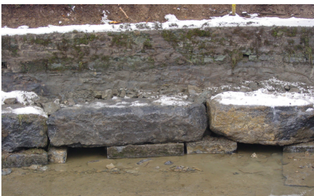
Photo 8: Caches à poissons au pied du mur de la berge gauche
