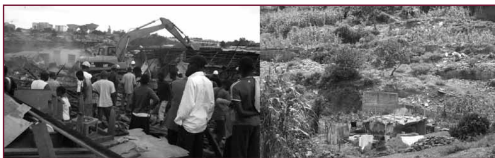
Figure 21.2. Démolition de constructions anarchiques et abandon d'espace démoli à Ntaba et Etéack 2 . Photos : Hélène Marigoh Bouquet et Célestin Kaffo.
